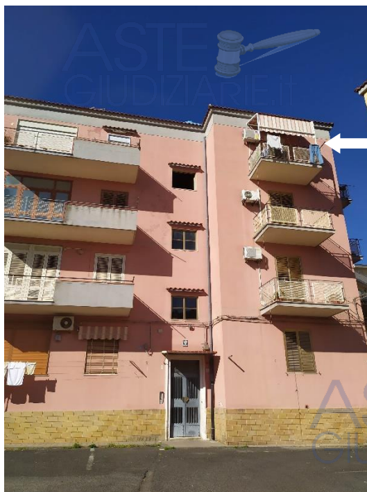
Prospetto est con indicazione dell'appartamento pignorato
