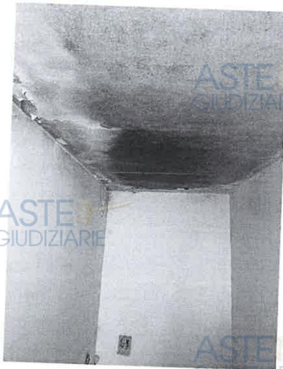
Degrado materico nel solaio del vano scala
