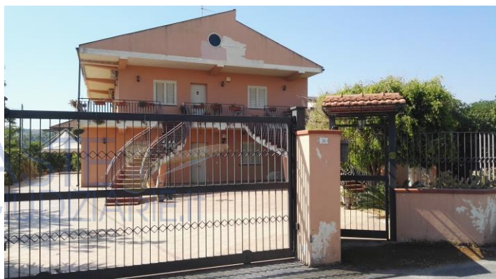
Foto 1 - Prospetto Nord su stradella privata di accesso
