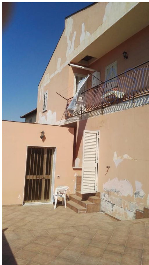
Foto 2 – Prospetto a Sud e pertinenza
