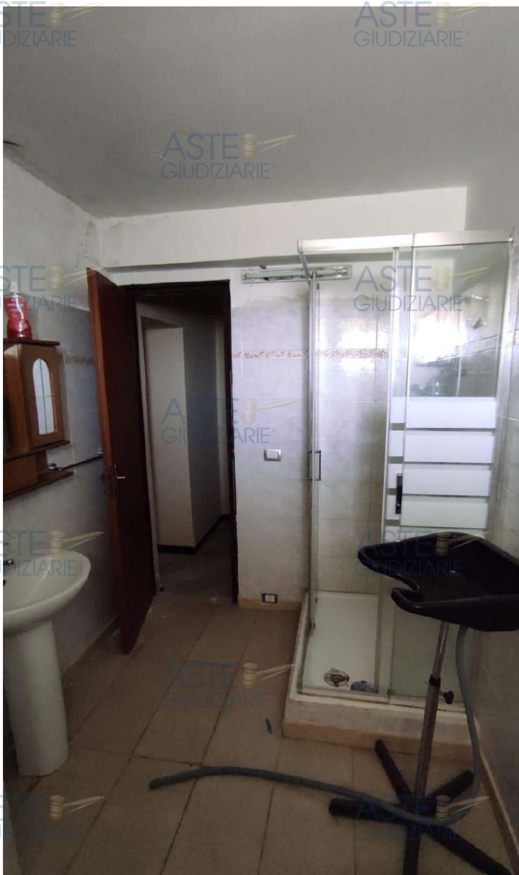
Foto n.7– Vano Wc a P.1°
