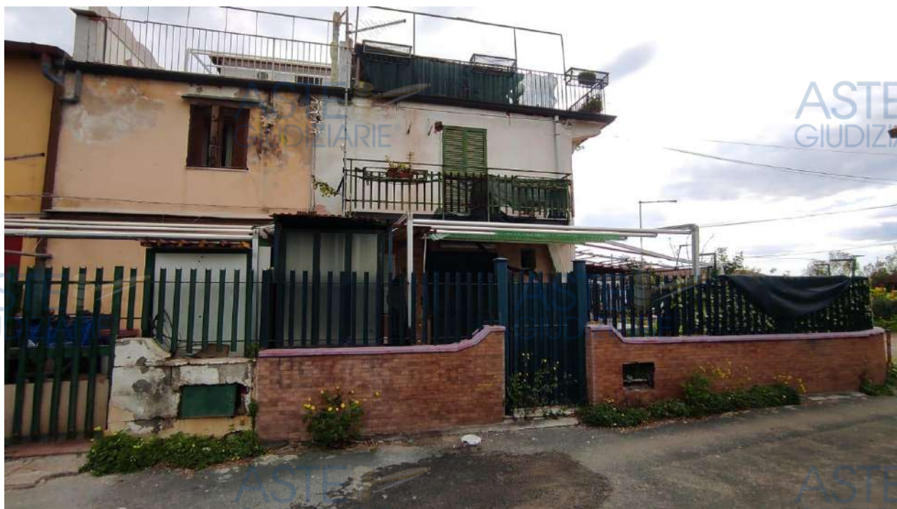
Foto n.1 – Visione dell'esterno dell'immobile – Prospetto Principale
