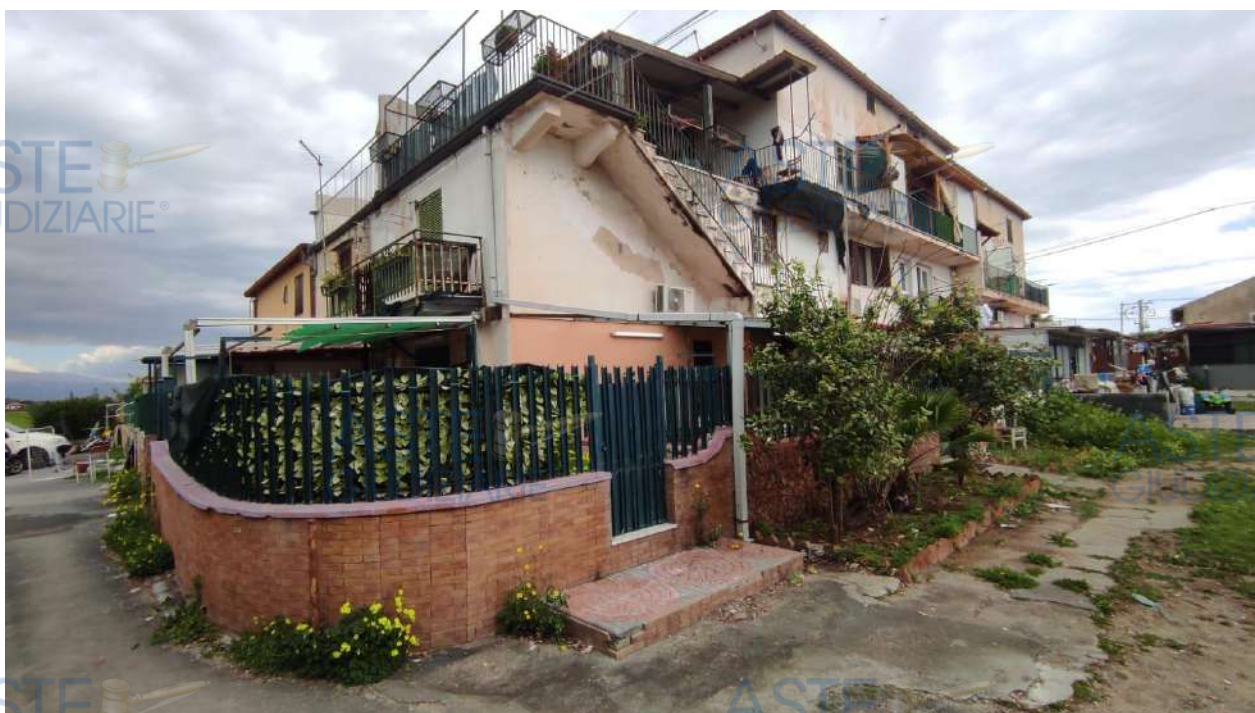
Foto n.2 – Visione dell'esterno dell'immobile –Prospetto laterale
