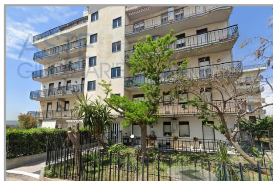
Foto del prospetto principale con ingresso all'edificio
