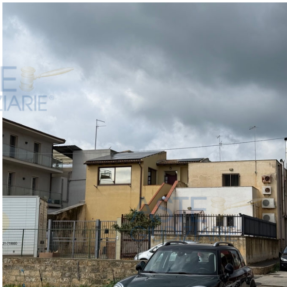
Vista dell'immobile da via Luciano Rinaldi
