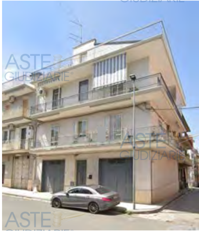
Prospetti nord est e sud est dell'edificio – Immagine tratta da Google maps
