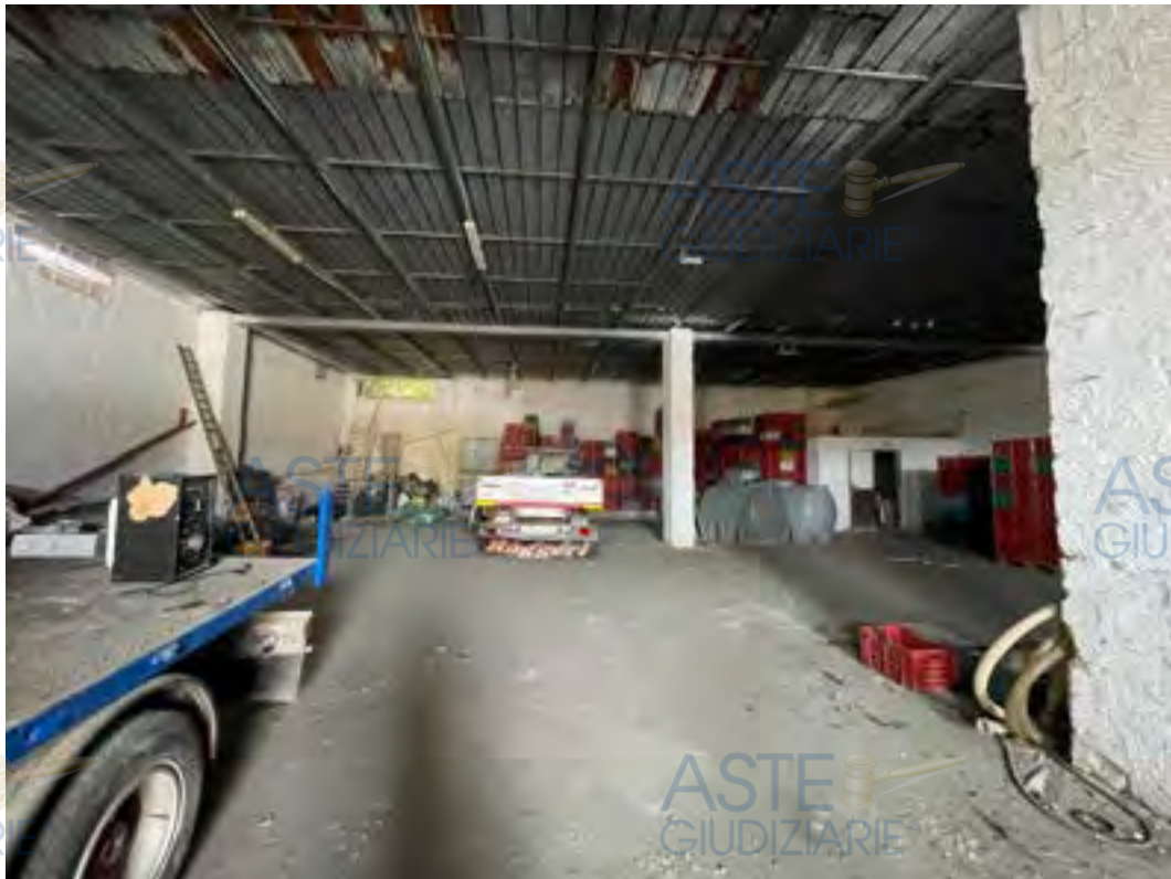
Interno del magazzino con ingresso da strada di Contrada Sant'Antonio
