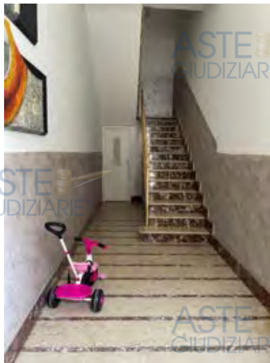
Vano scala dell'edificio bifamiliare
