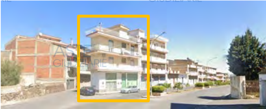
Contesto urbano in cui è l'edificio pignorato indicato con linea continua gialla
