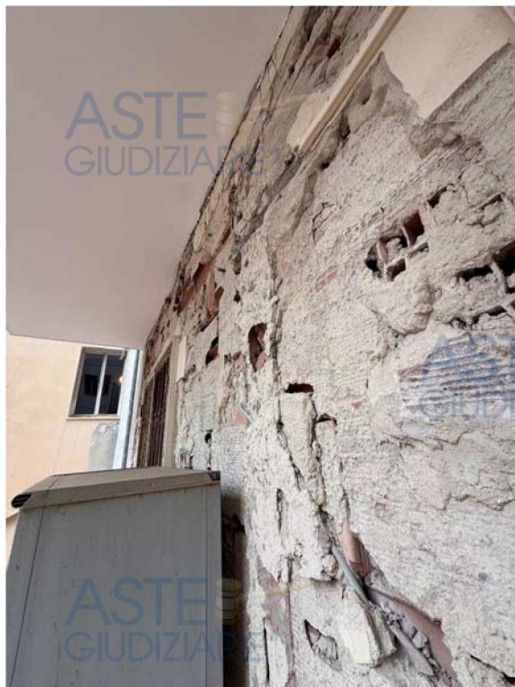
Stato del prospetto esterno
