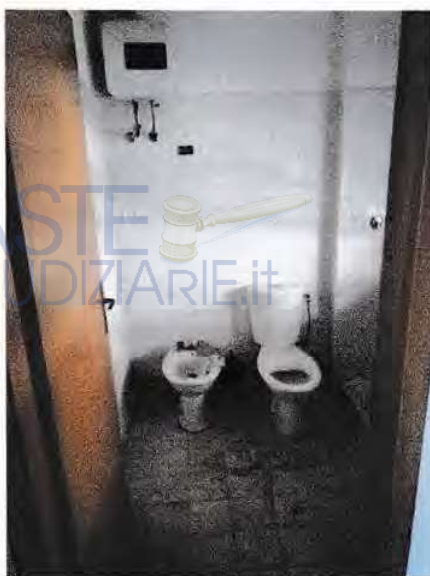
Foto 15: vano wc vista dal corridoio
