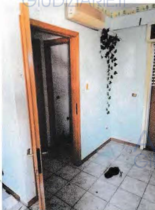
Foto 13: vano cucina/ingresso dis
