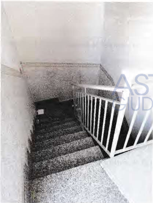
Foto 20: piazzetta sbarco terzo piano
