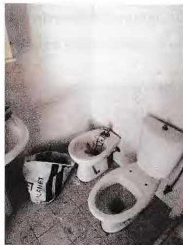
Foto 9: vano wc lato corridoio
