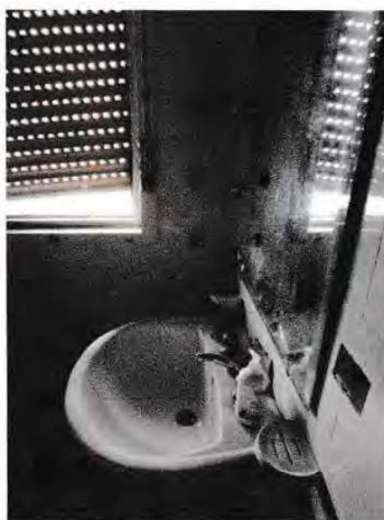
Foto 16: vano wc vista dall'interno
