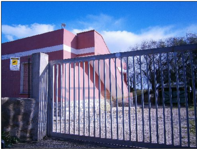
Foto 1: Ingresso al villino sito in Pachino in contrada Mercieri/Saiazza censito all'N.C.T. Fg.23, P.la 934.
