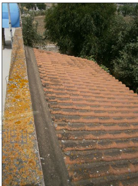
Foto 16: copertura del vano cucina-soggiorno
