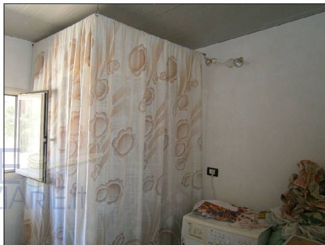
Foto 22: particolare dello stesso vano
