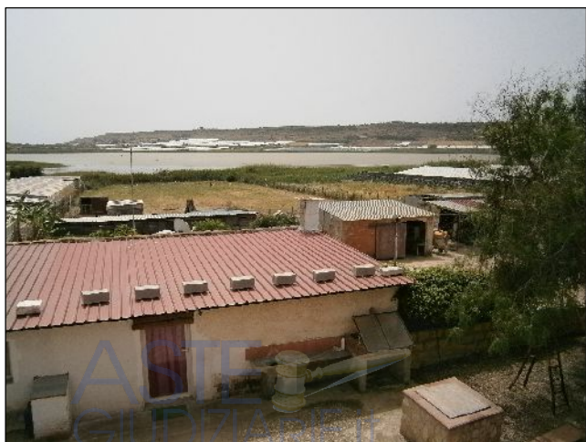
Foto 17: vista dell' immobile-deposito non censito, del volume tecnico e delle strutture in legno con in fondo il pontone Merghella confinante con il 222
