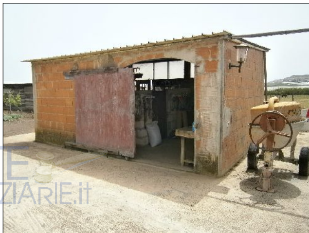
Foto 28: vista del locale adibito a deposito che insiste sulla p.lla 210
