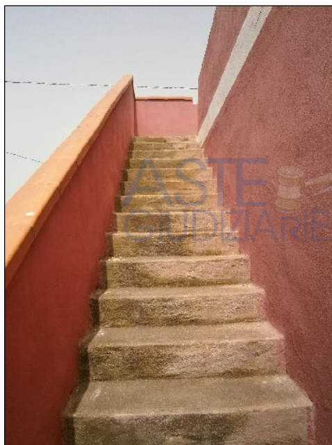
Foto 14 : scala di accesso alla terrazza calpestabile posta sul prospetto sud/ovest.
