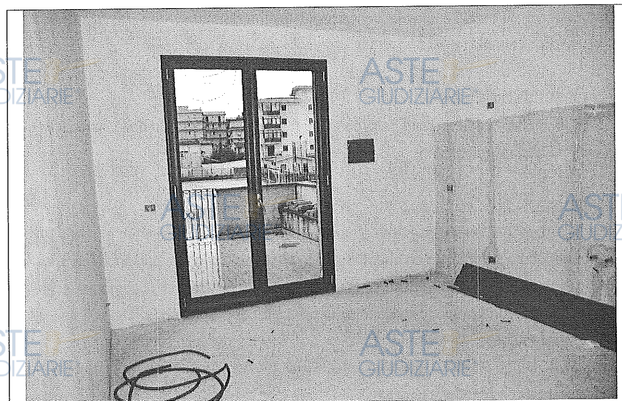
Foto n. 38 – Vano cucina ancora allo stato grezzo
