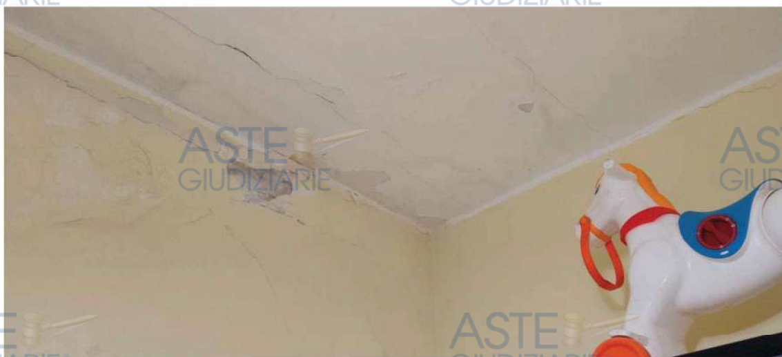
Foto 11 infiltrazioni vano letto
