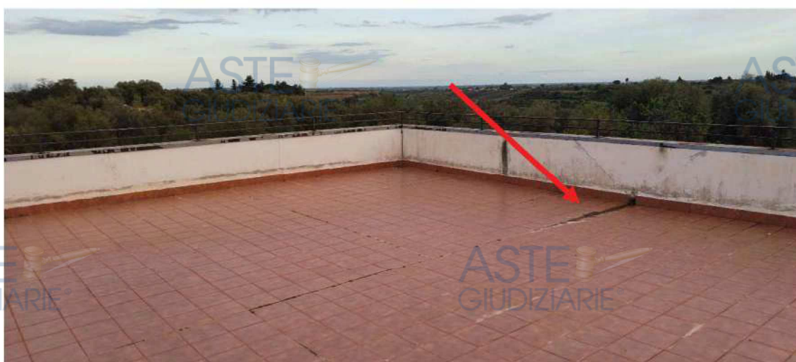
Foto 16 lesioni lastrico solare
