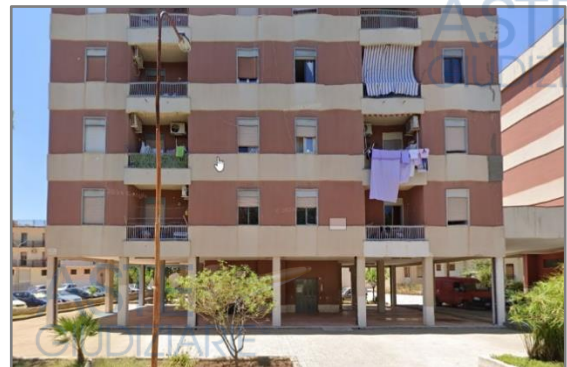
Foto d'ingresso prospetto principale
