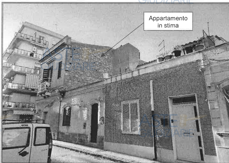
Foto n° 3 – prospetto sul retro prospiciente via Enna
