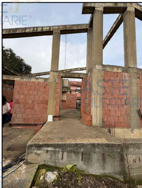
Foto_12 Struttura a rustico
