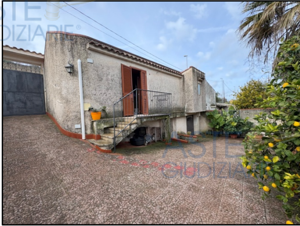
Foto_1 Ingresso corpo di fabbrica n.1
