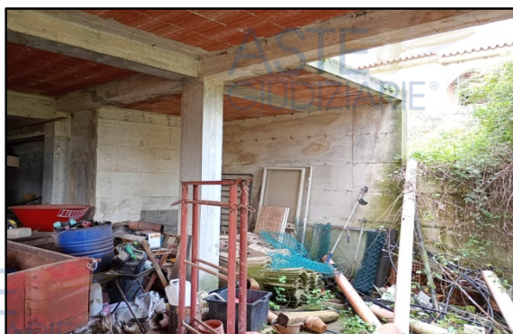
Foto_14 Struttura a rustico seminterrato
