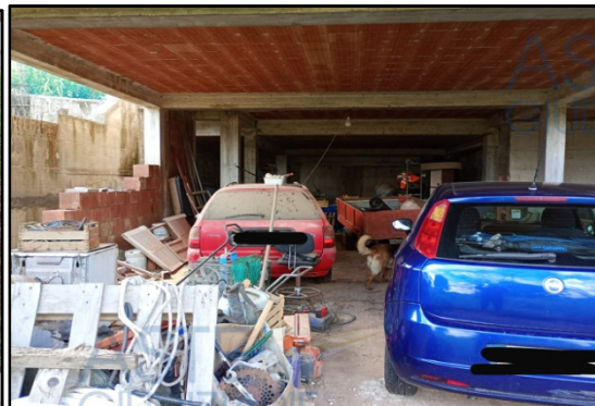
Foto_15 Struttura a rustico seminterrato
