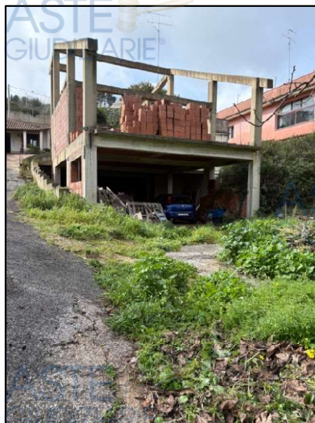
Foto_13 Struttura a rustico
