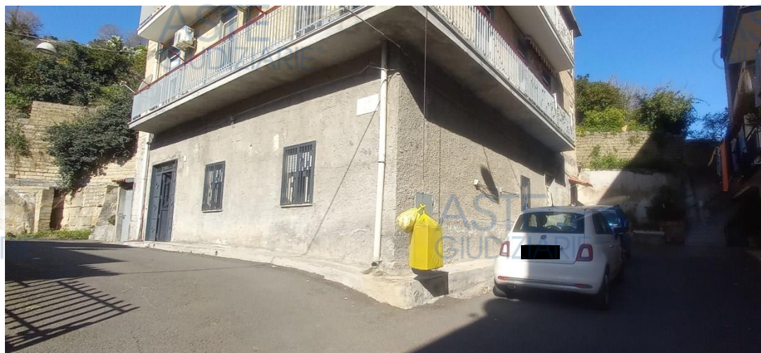
Foto 2 – Immobile "1A" – Unità immobiliare al P.T., ad angolo tra via Teodosio e via Fano
