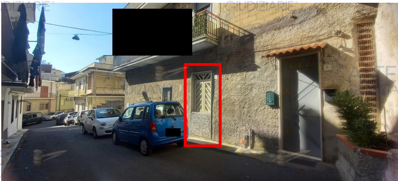
Foto 3 – Immobile “1A” – Prospetto di via Teodosio (parzialmente tamponato)
