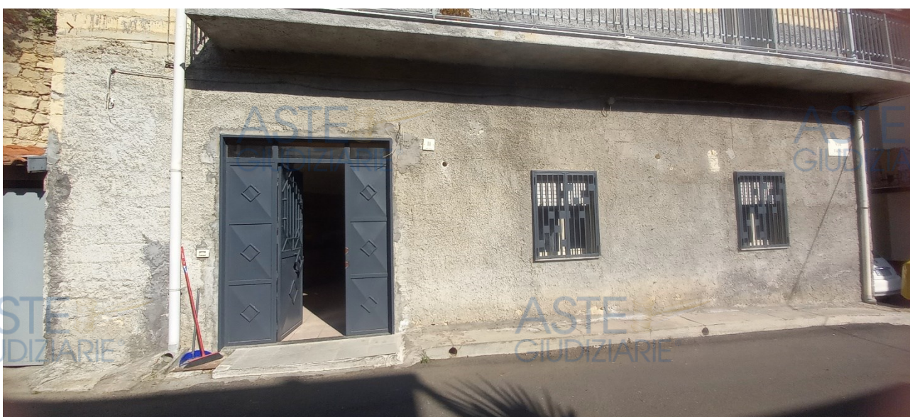
Foto 4 – Immobile “1A” – Prospetto principale di via Fano
