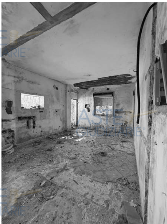
Cucina al piano terra (villa p.lla 256, sub. 1)
