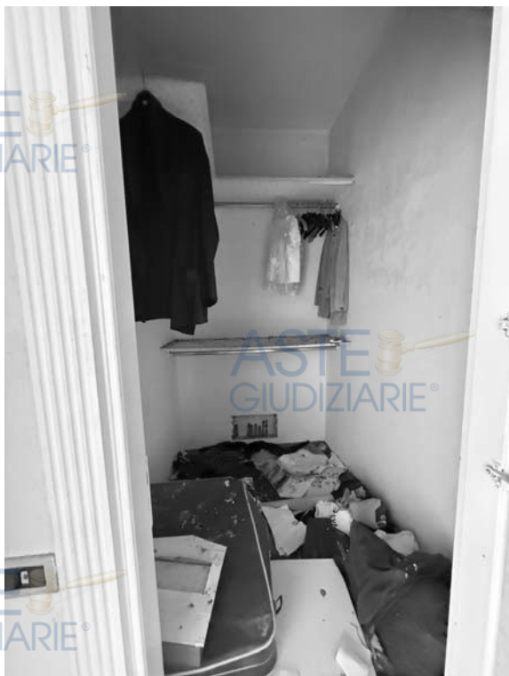
Ripostiglio al piano primo (villa p.lla 256, sub. 1)
