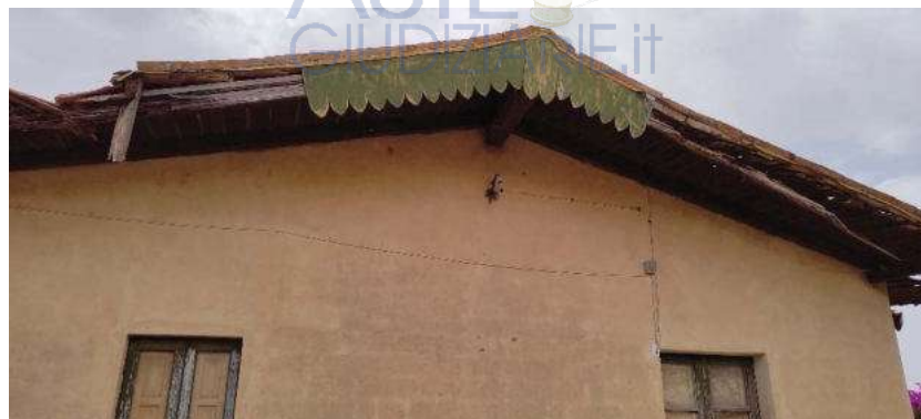
Foto 48 facciata Est casa custode
