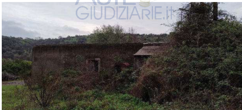
Foto 67 locale tecnico plla 237
