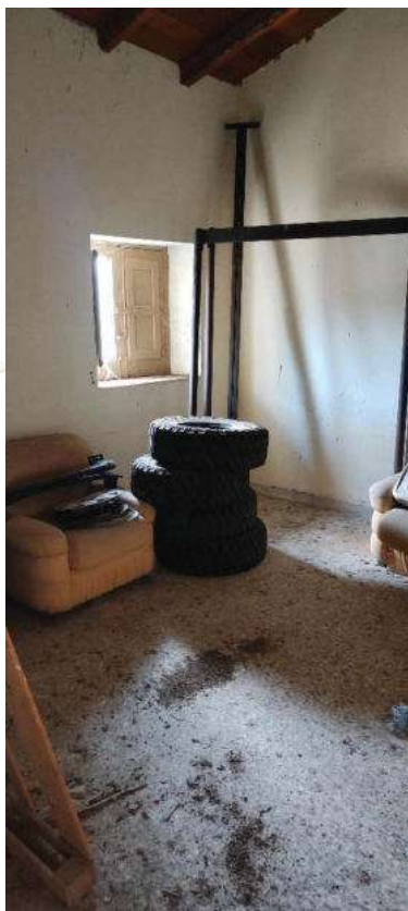
Foto 45: vano casa custode
