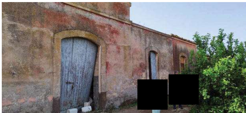
Foto 6: prospetto lato nord piano terra
