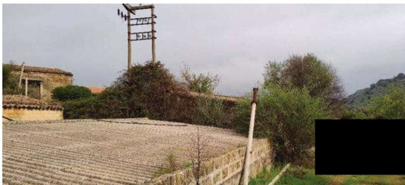
Foto 71 locale vasca plla 237
