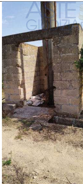
Figura 17: base pala eolica
