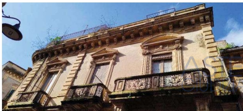
Foto 19: facciata lato Est
