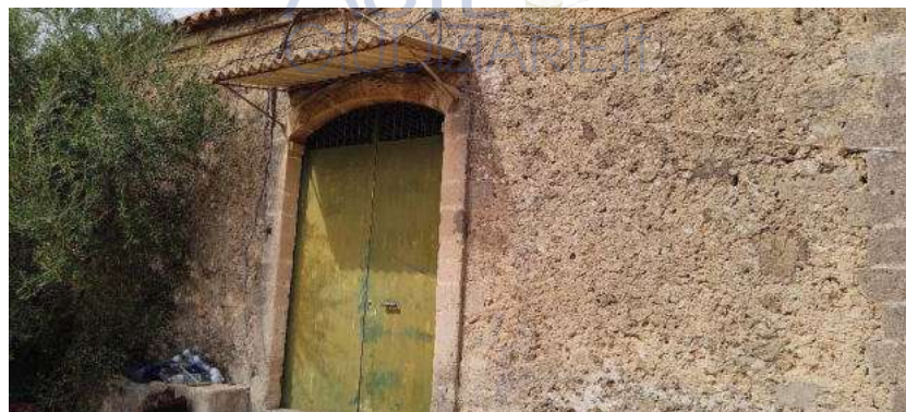
Foto 52 ingresso deposito carburante lato Sud
