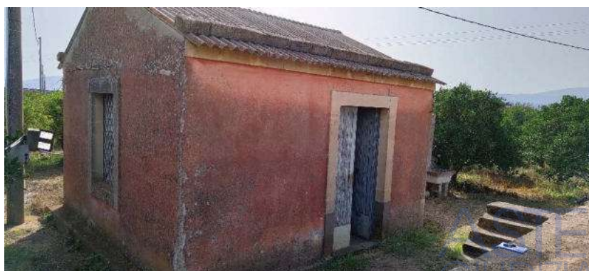
Figura 4 locale tecnico pozzo su p.la 190
