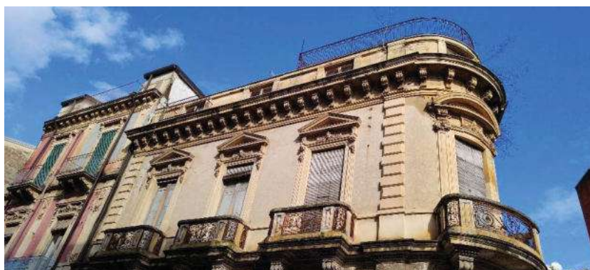
Foto 21: facciata lato Sud
