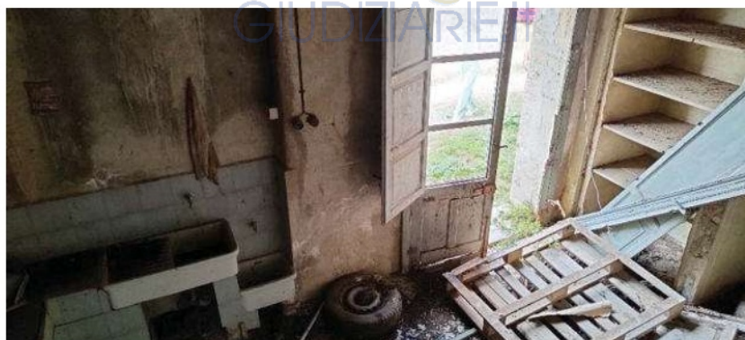
Foto 60 deposito lato nord
