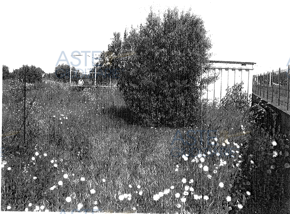
IMMOBILE G: Vista interna.
