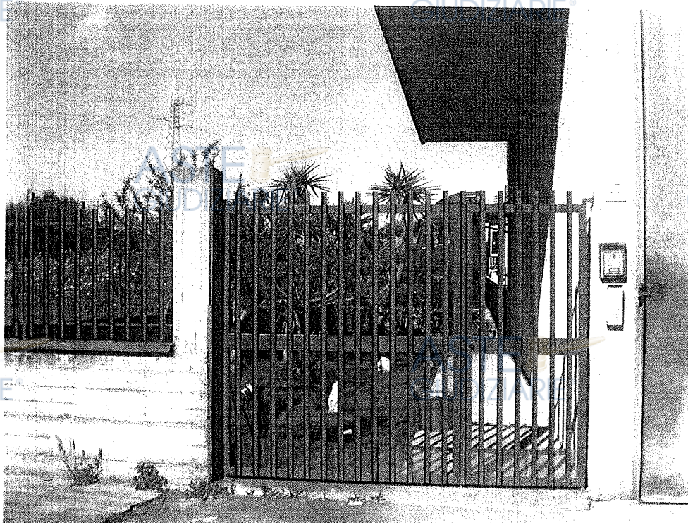
IMMOBILE F: Vista esterna fabbricato (accesso al primo piano).
