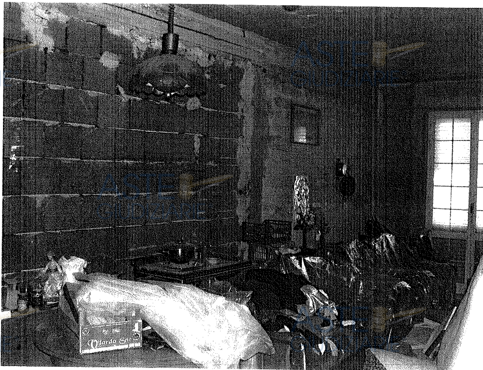
IMMOBILE F3: Vista interna.
