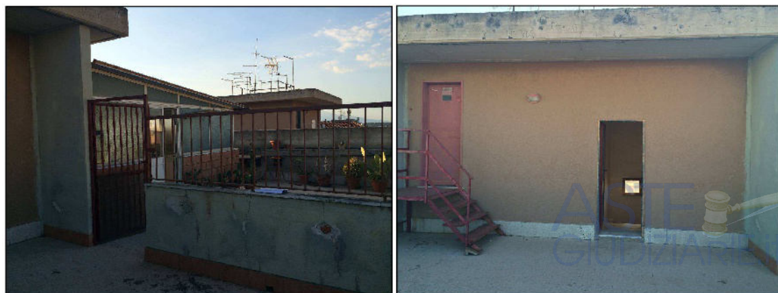
Figura 15: porta vano scala e terrazzo
