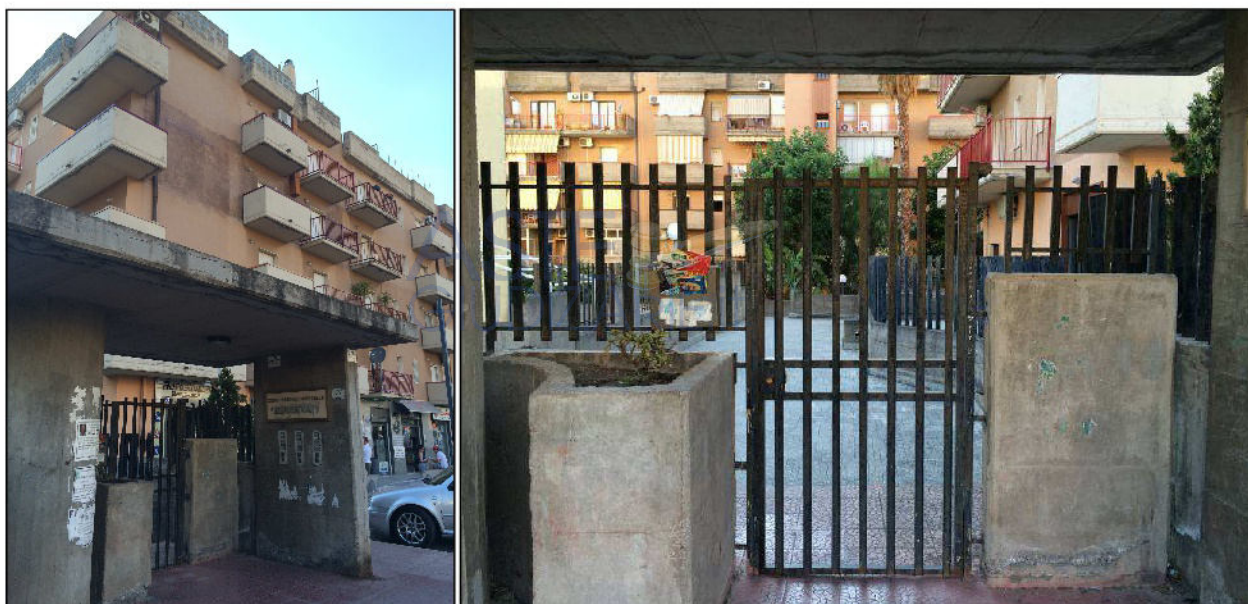
Figura 7: ingresso pedonale condominiale dalla via Gramsci
