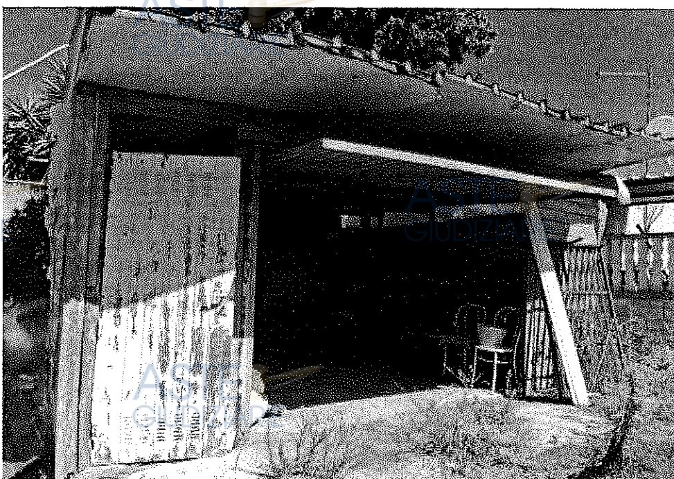
Foto 18 – Immobile "2A" – Deposito attrezzi in legno/lamiera zincata
