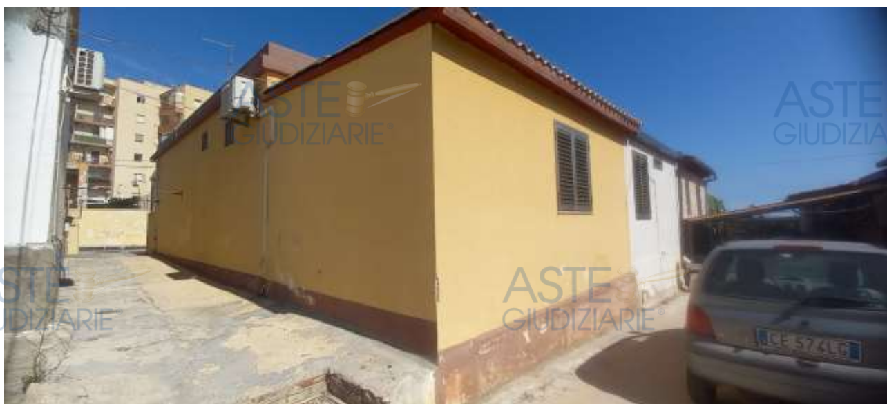
Foto 4 – Immobile “1A” – Prospetto posteriore su area condominiale
