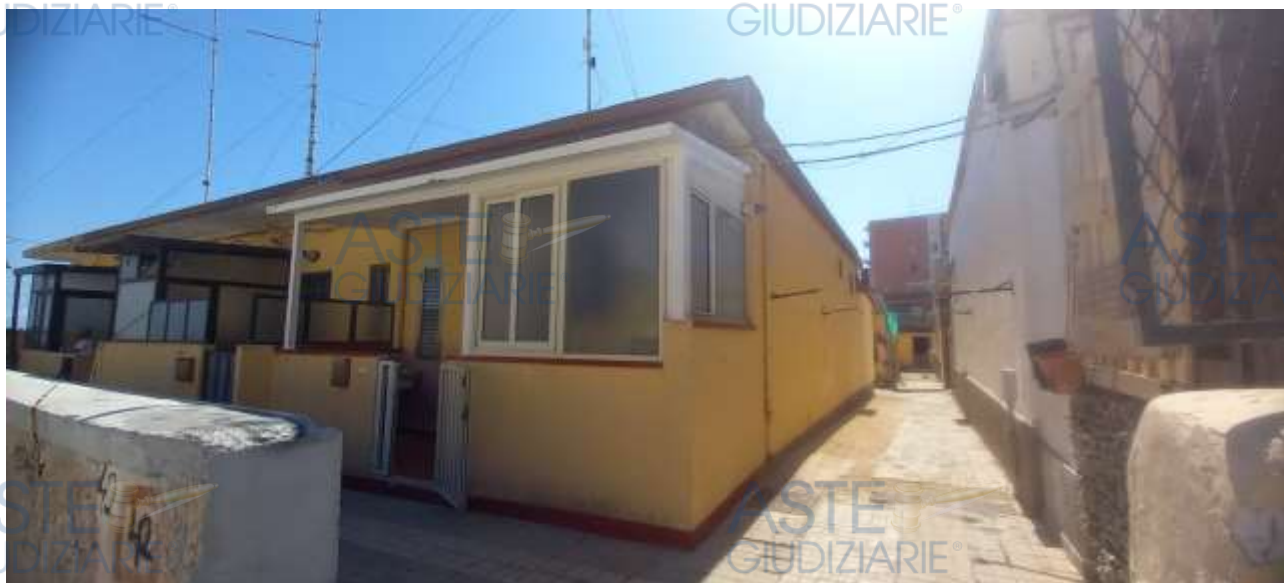
Foto 3 – Immobile “1A” – Prospetto principale su via Corsica
