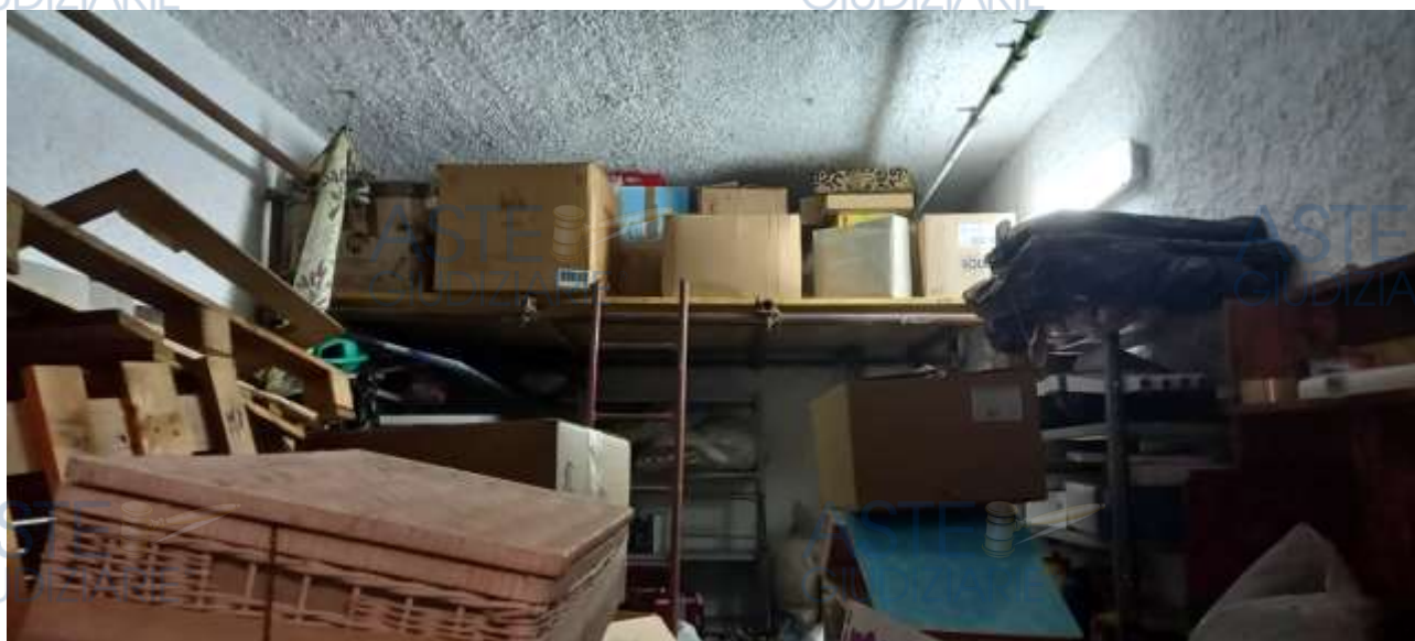
Foto 8 – Immobile “2A” – Garage al piano sottostrada
