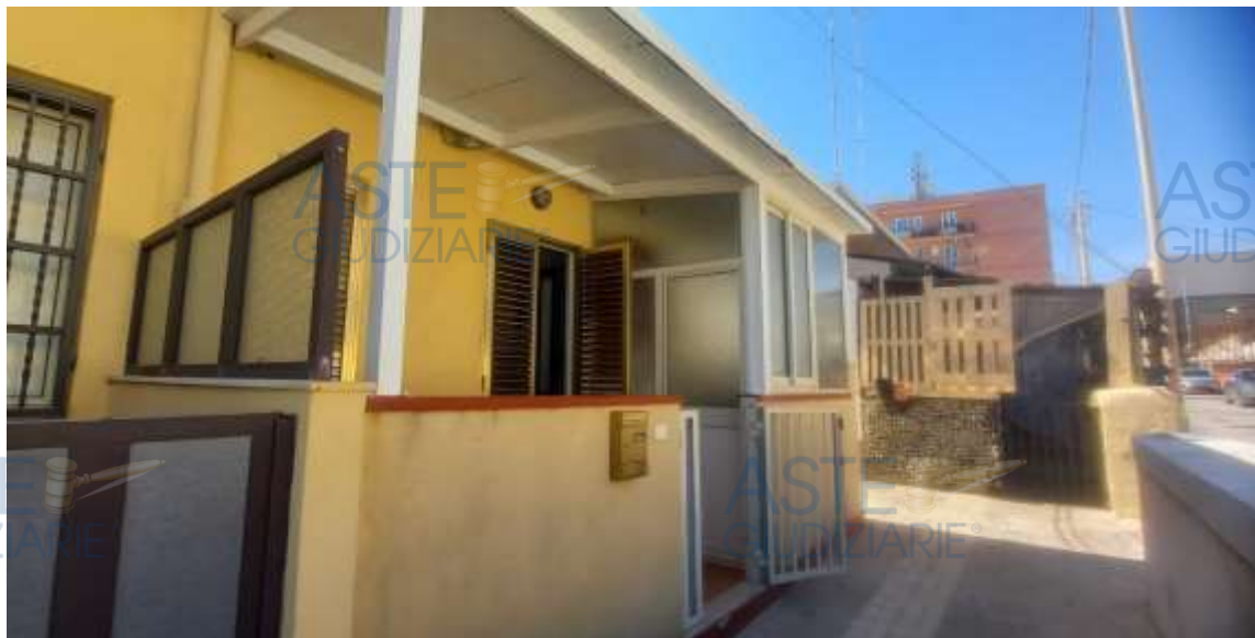
Foto 5 – Immobile “1A” – Prospetto principale su via Corsica
