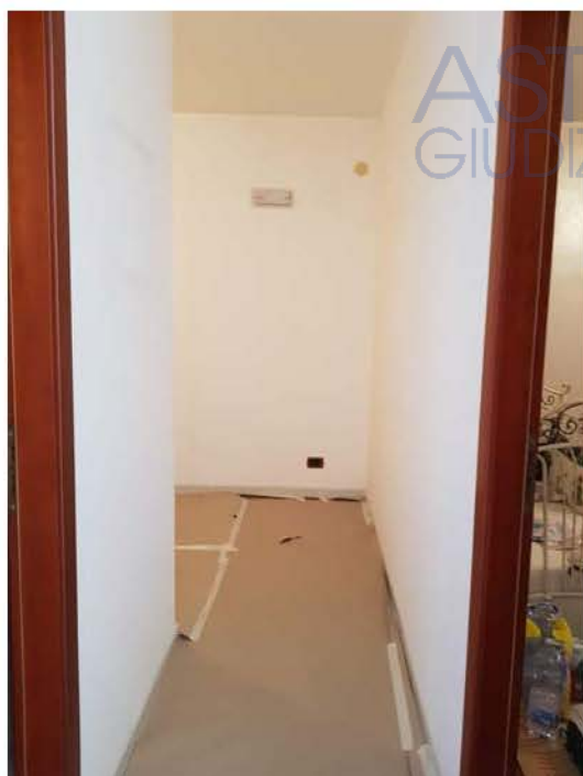
Vista del disimpegno (Dis)
