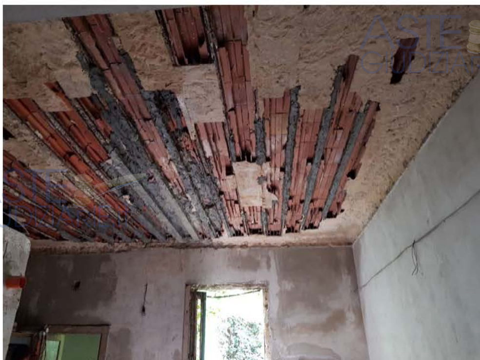
Vista del solaio del deposito (D1)
