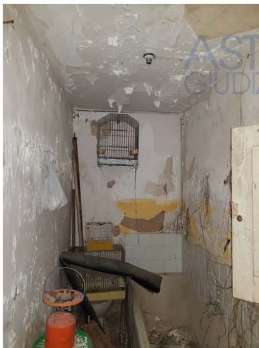
Vista del servizio igienico (Wc)
