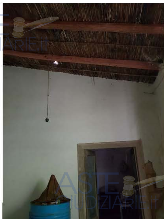
Vista della copertura del deposito (D2)
