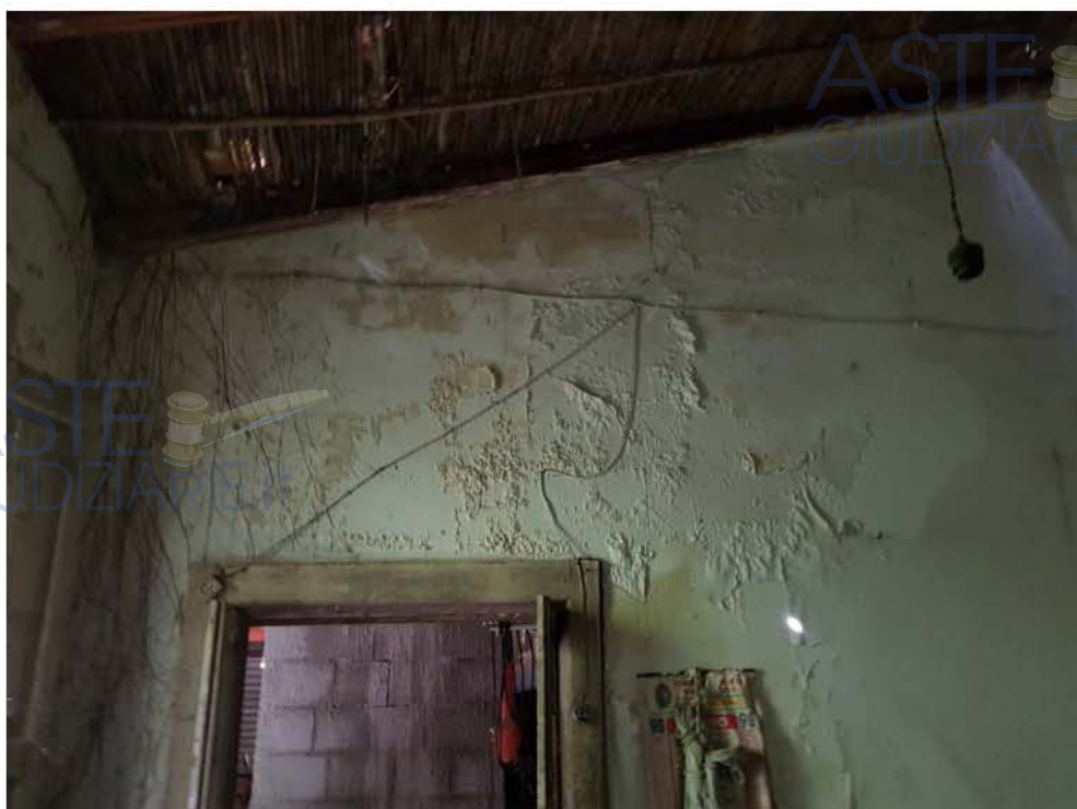
Vista del solaio del deposito (D2)
