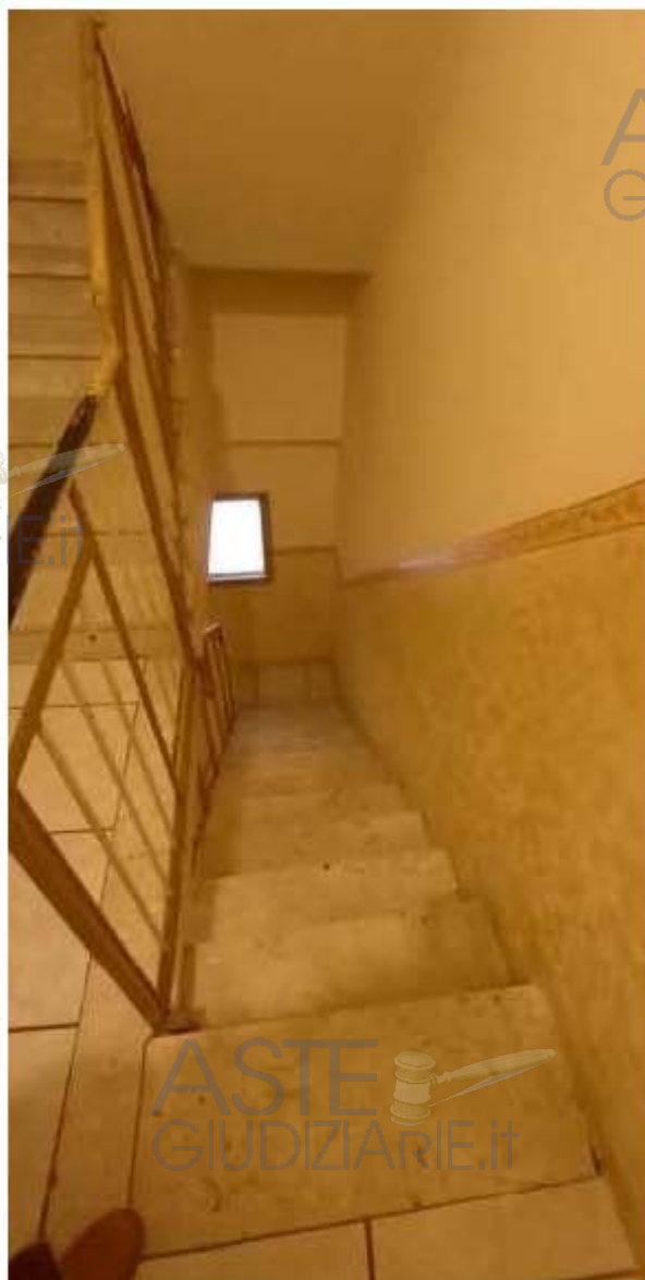
Foto 10 – Immobile “1A” – Vano scala da I P a II P
