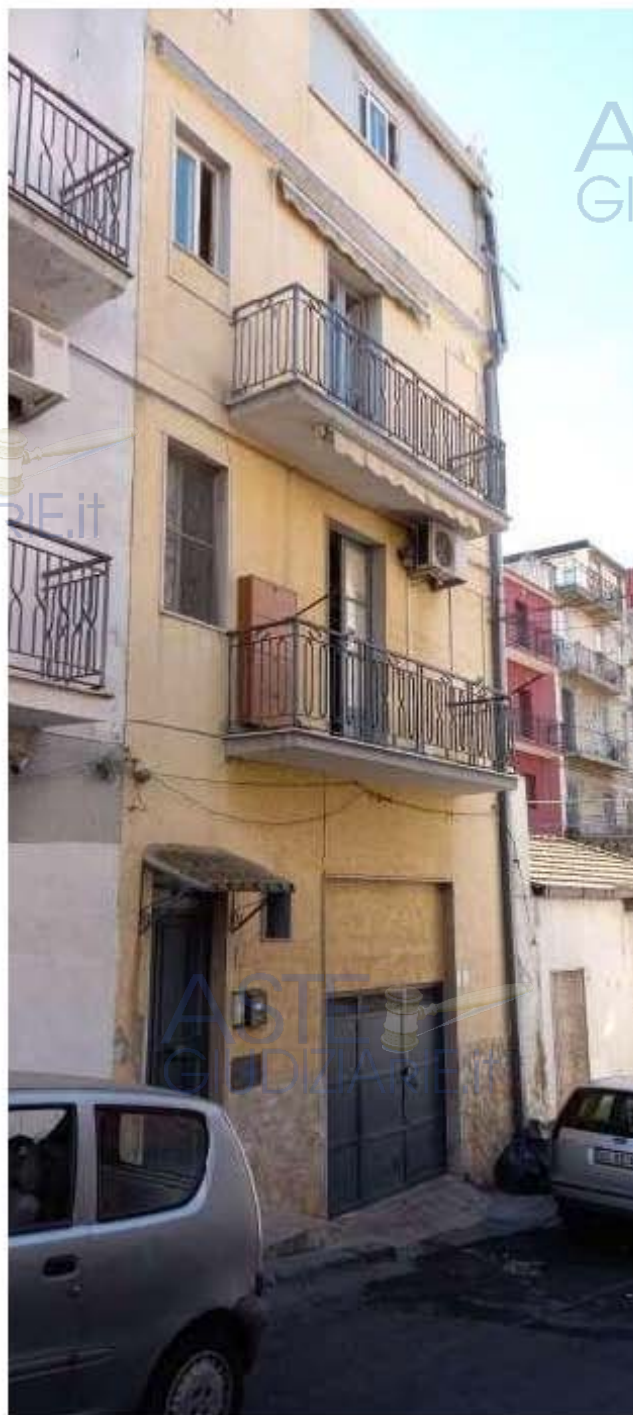
Foto 2 – Immobile “1A” – Prospetto di via G. B. Grassi
