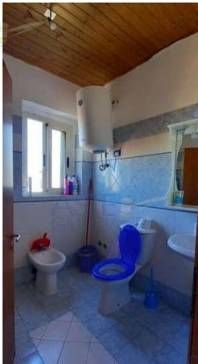
Foto 15 – Immobile “1A” – Bagno a III P
