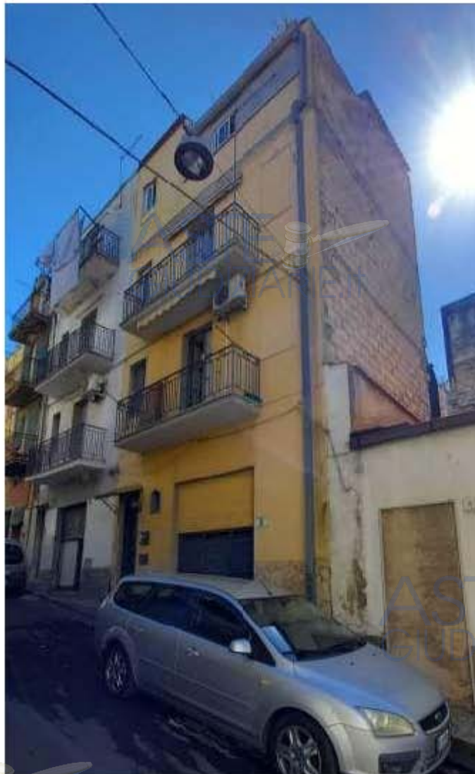
Foto 1 – Immobile "1A" – Prospetto di via G. B. Grassi
