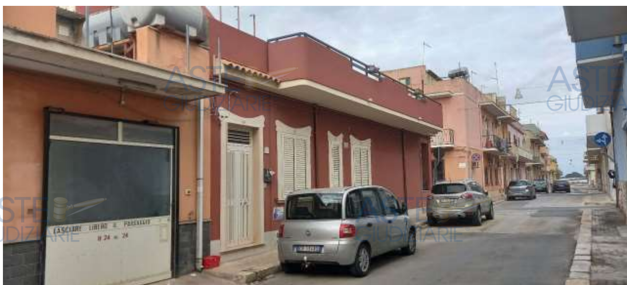
Foto 3 – Immobile “1A” – Prospetto di via dei Tulipani
