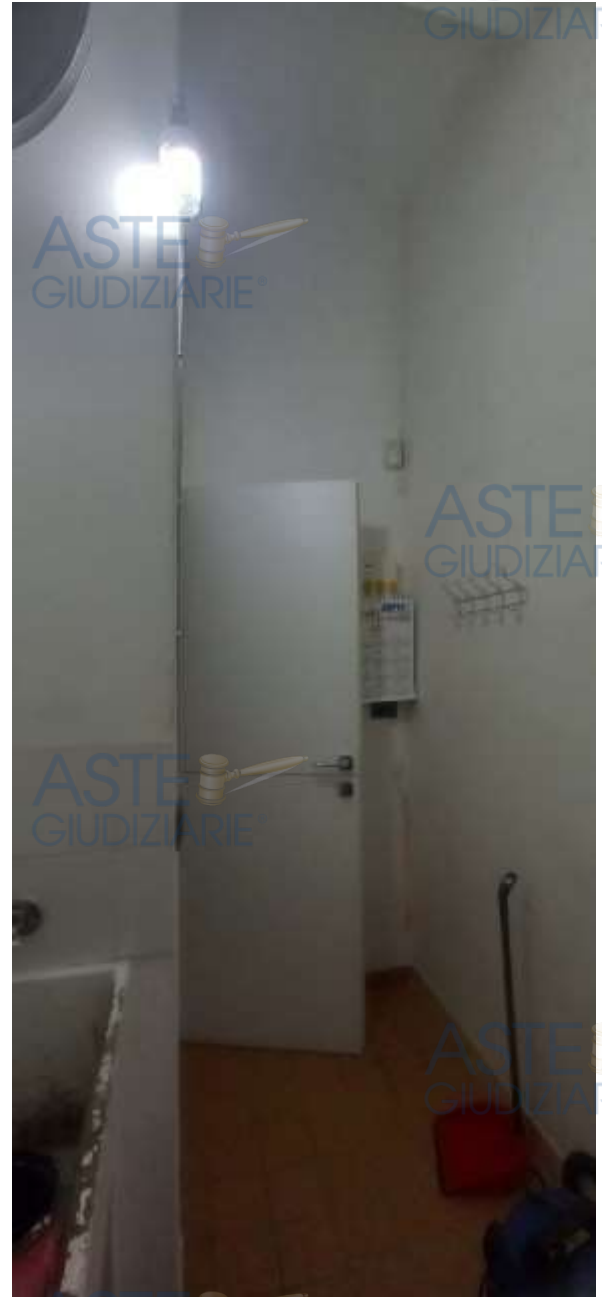
Foto 11 – Immobile “1A” – Ripostiglio
