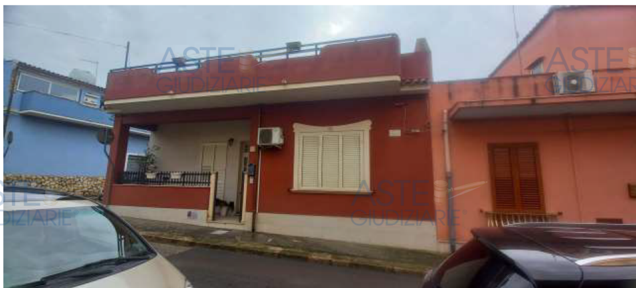
Foto 1 – Immobili "1A" – Prospetto di via De Sanctis
