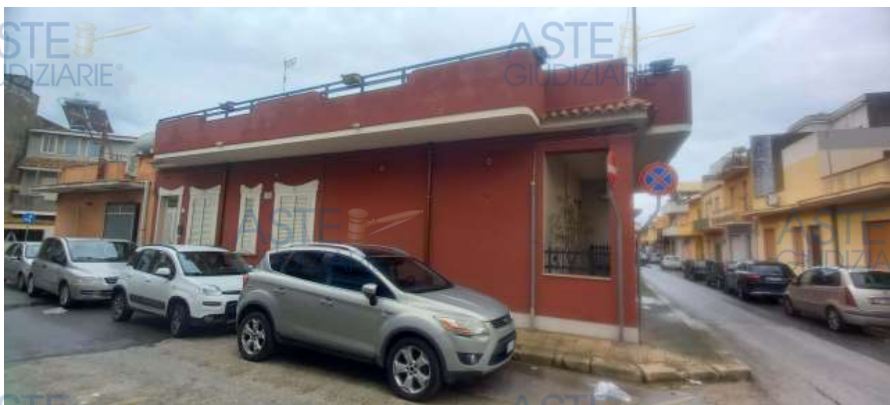
Foto 2 – Immobile “1A” – Prospetto di via dei Tulipani
