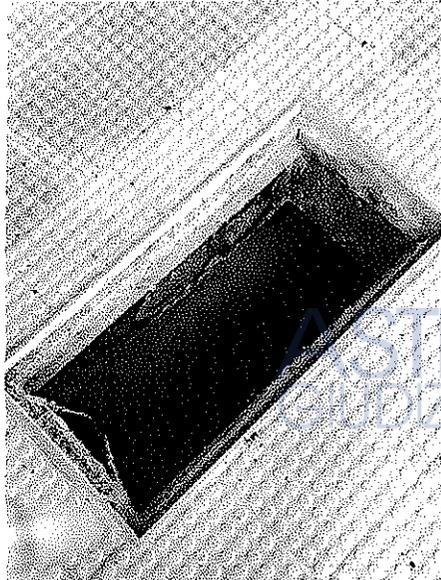
FOTO 5 – condotte U.T.A. al di sotto della pavimentazione, fortemente ossidate
