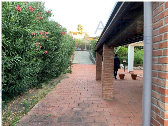
Figura 5: rampa d'ingresso ed area pavimentata
