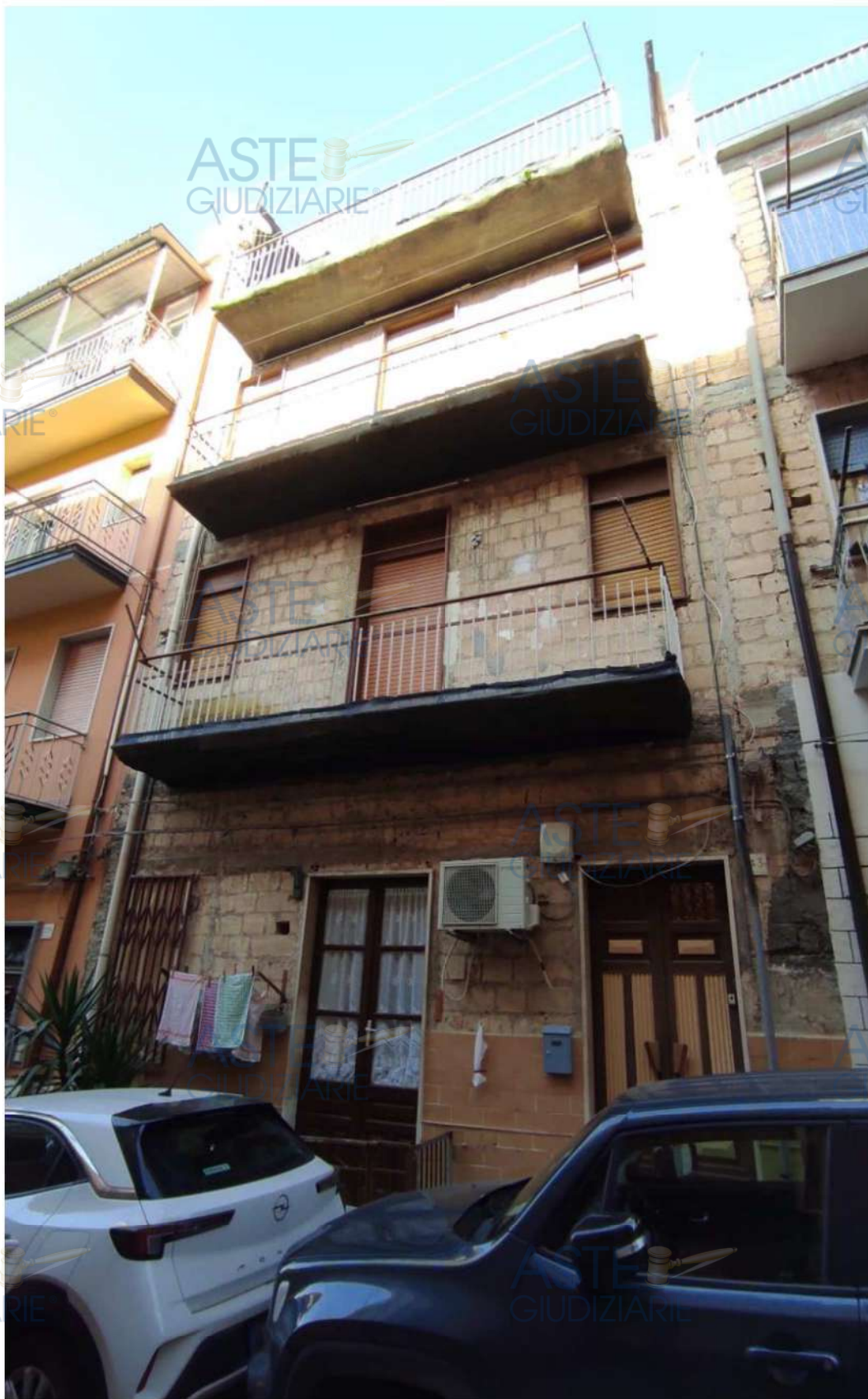
Foto n.1 – Visione dell'esterno dell'immobile – Prospetto Principale
