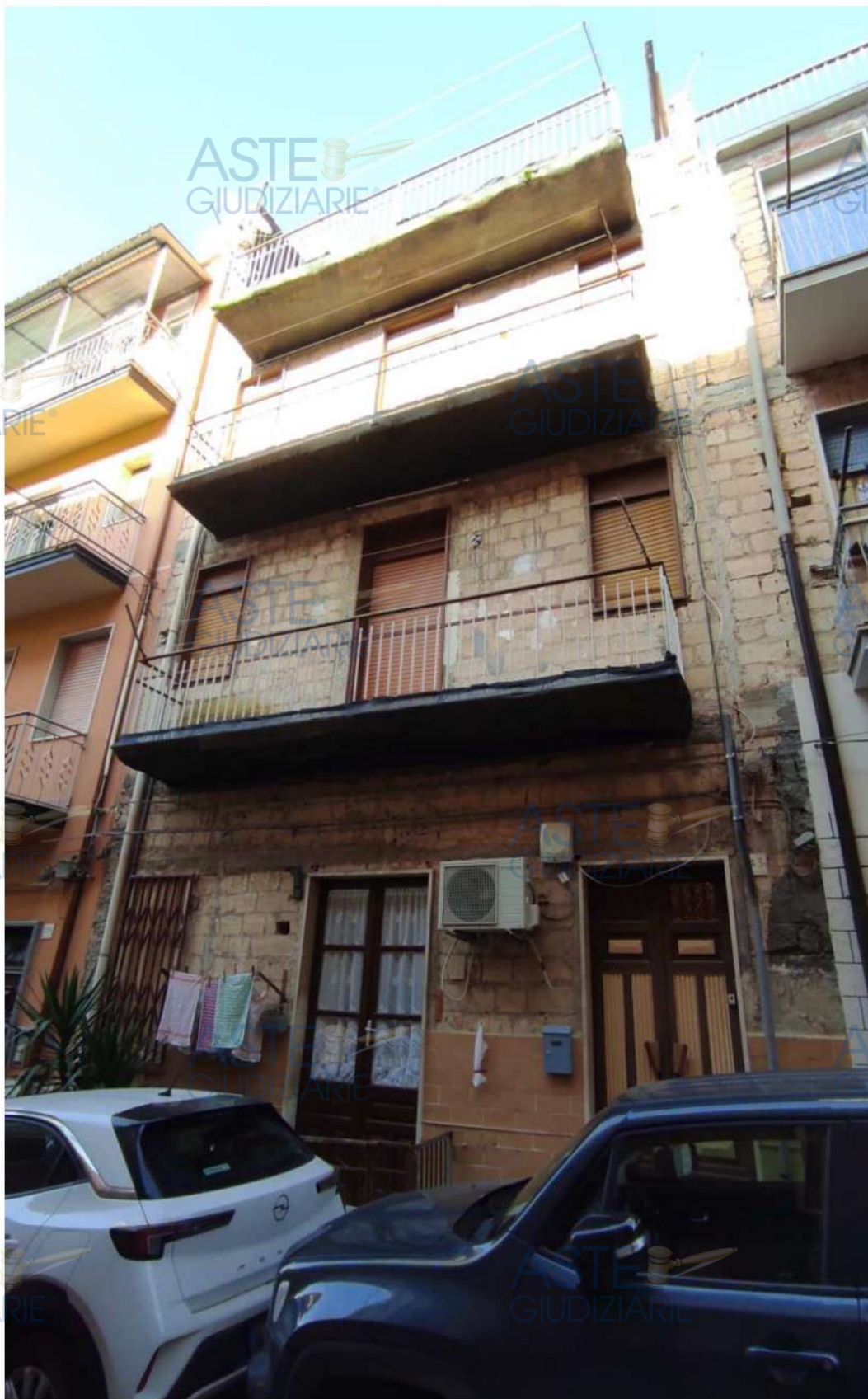
Foto n.1 – Visione dell'esterno dell'immobile – Prospetto Principale
