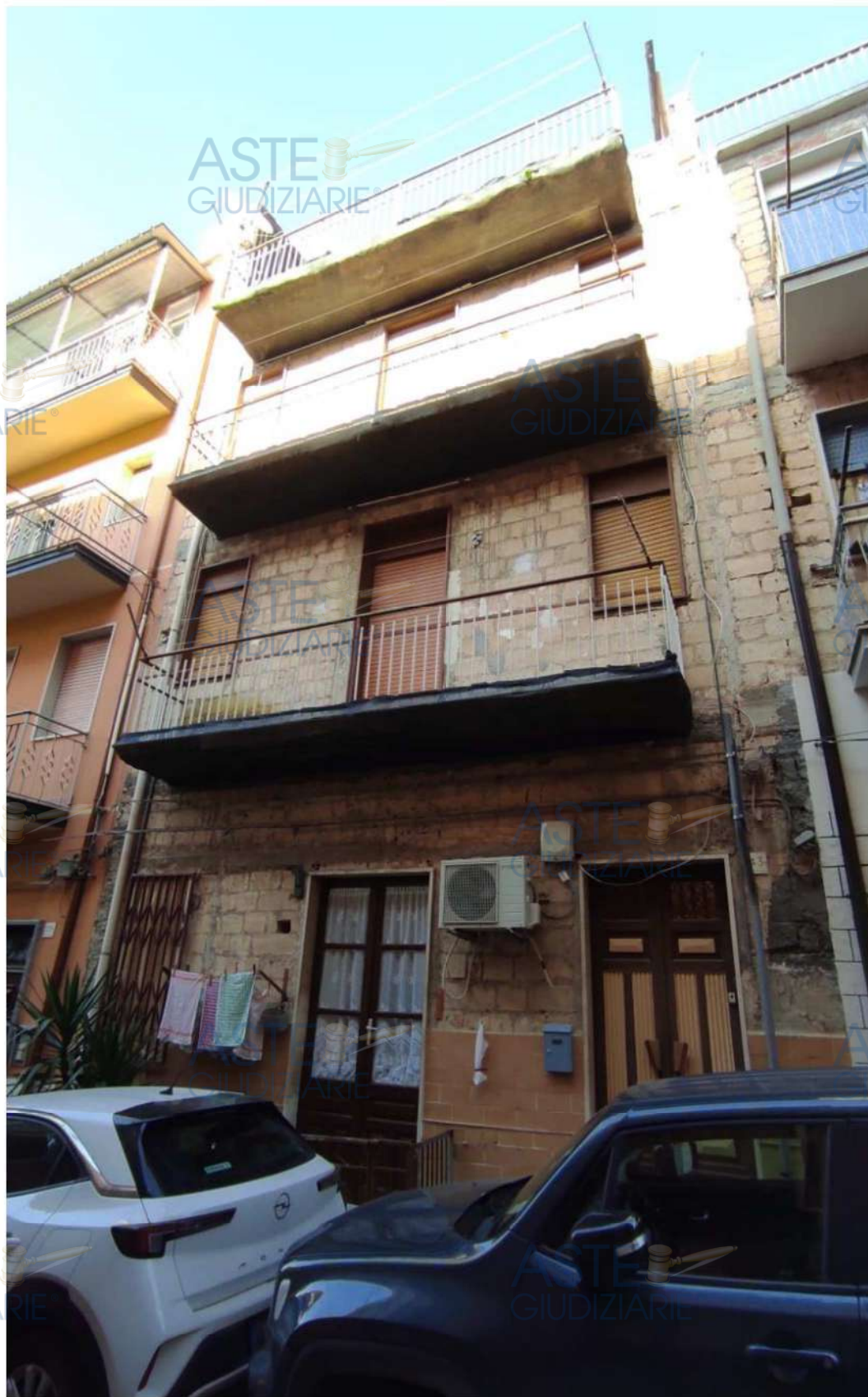
Foto n.1 – Visione dell'esterno dell'immobile – Prospetto Principale
