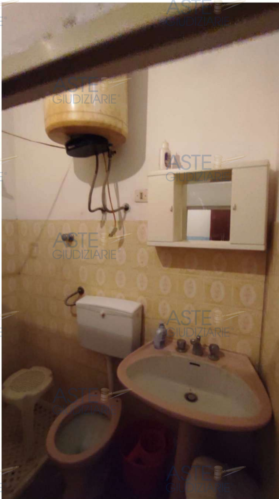
Foto n.5 – Vano w.c. a P.1°.
