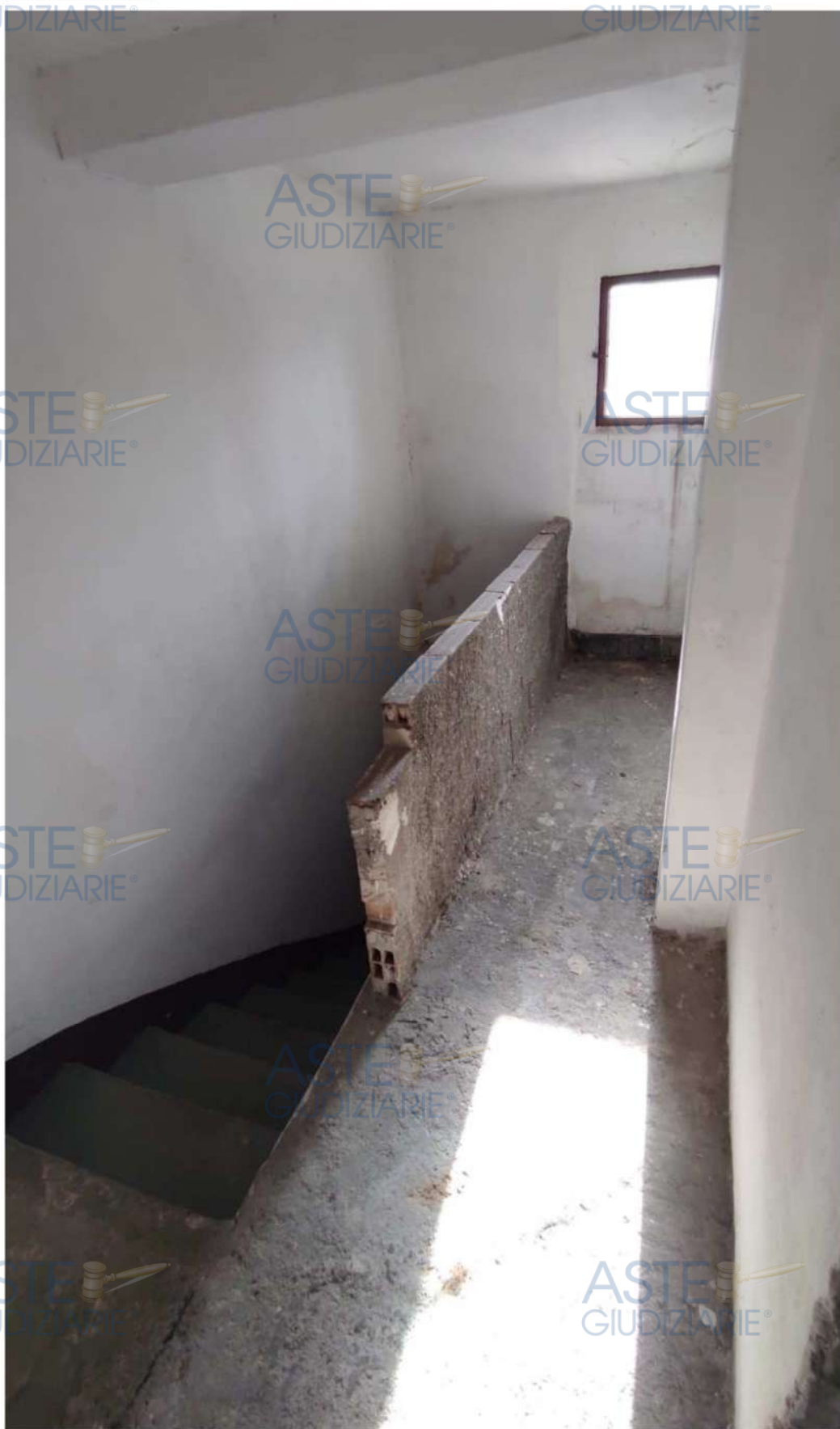
Foto n.1 – Vano scala e disimpegno a P.3°.
