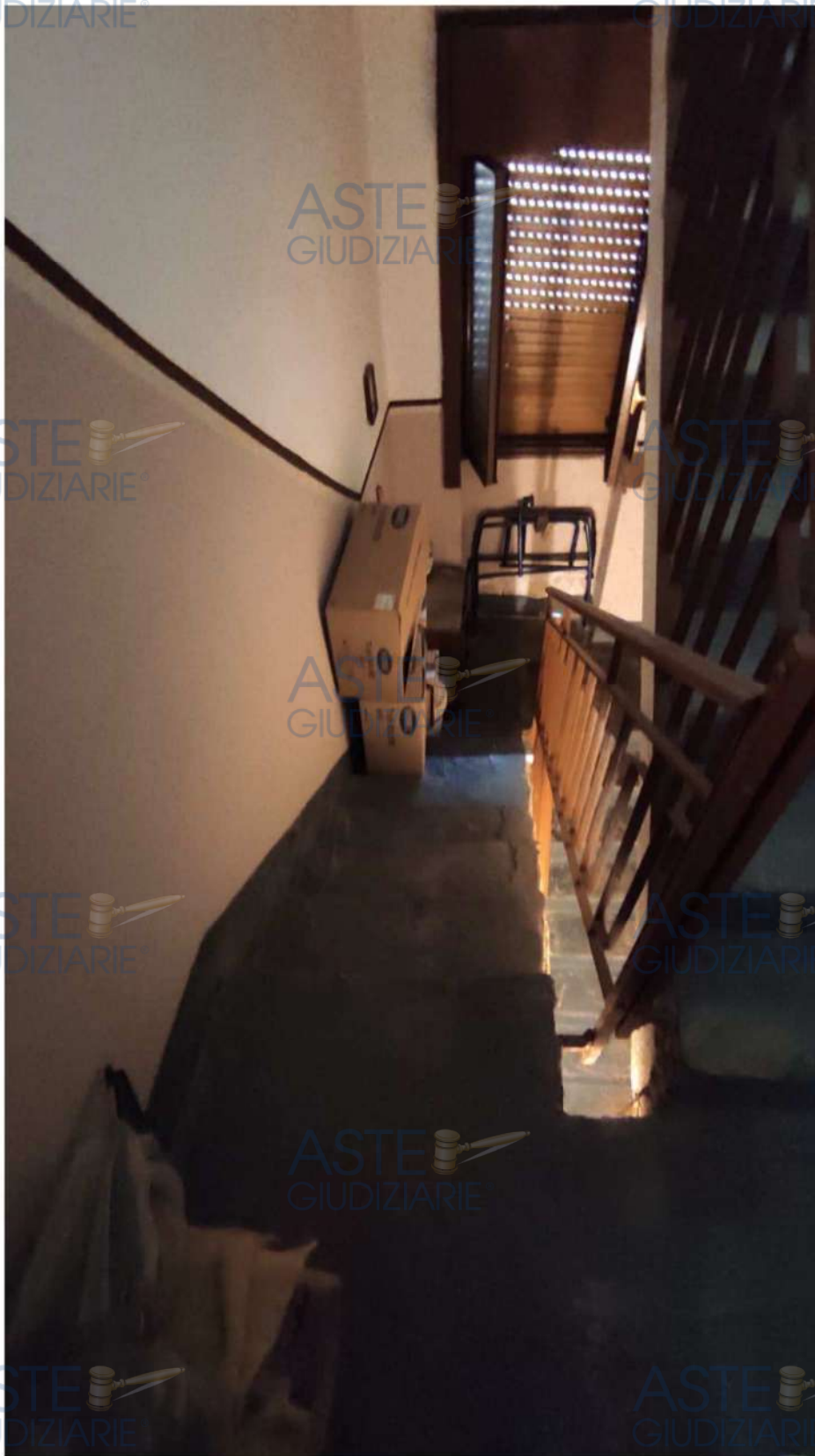
Foto n.1 – Vano scala a P.2°.
