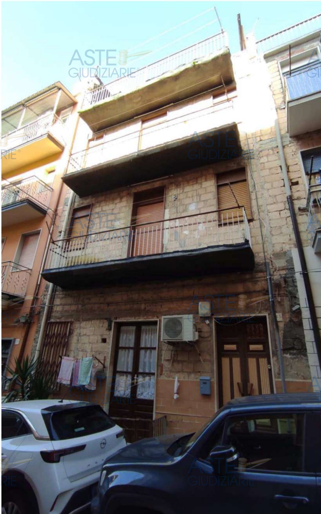
Foto n.1 – Visione dell'esterno dell'immobile – Prospetto Principale
