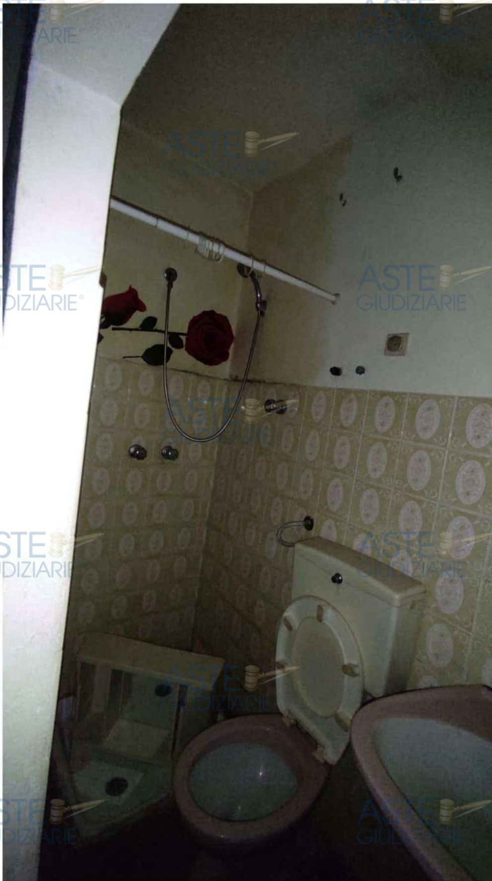
Foto n.5 – Vano w.c. a P.2°.
