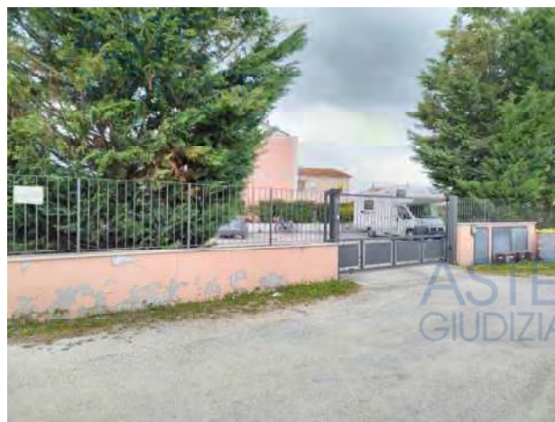
Recinzione lungo via lago di Corbara
