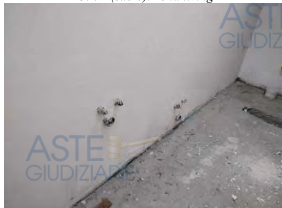
U.I. 1 (sub 6): servizio igienico
