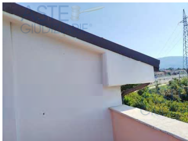
U.I. 2 (sub 7): particolare sporto di gronda
