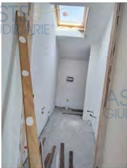
U.I. 1 (sub 6): servizio igienico
