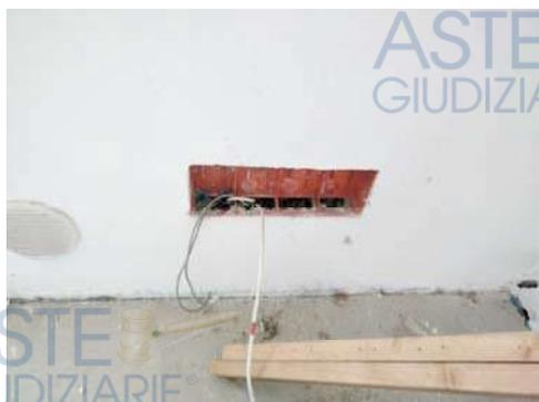
L'impianto elettrico è stato predisposto con le canalizzazioni interne ai muri e le scatole, ma il cablaggio non è stato completato.
