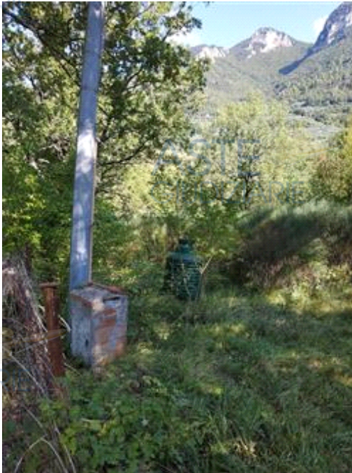
Terreno agricolo dove è posto il bambolone del GPL
