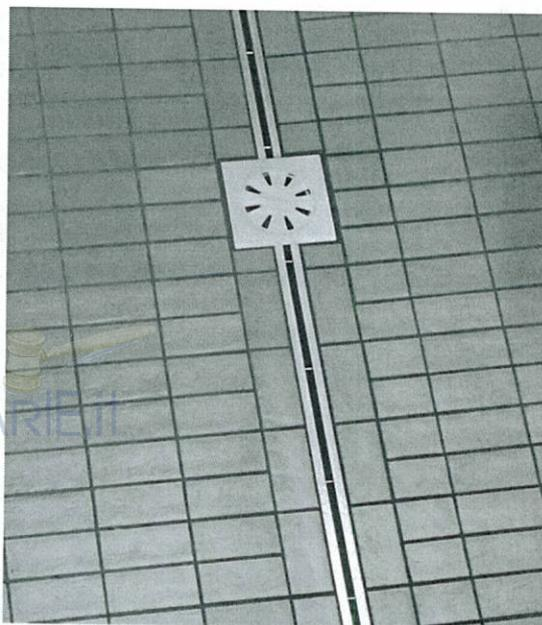
Foto 18 \_ Piano Seminterrato: Pavimento in klinker con impianto di scolo/areazione
