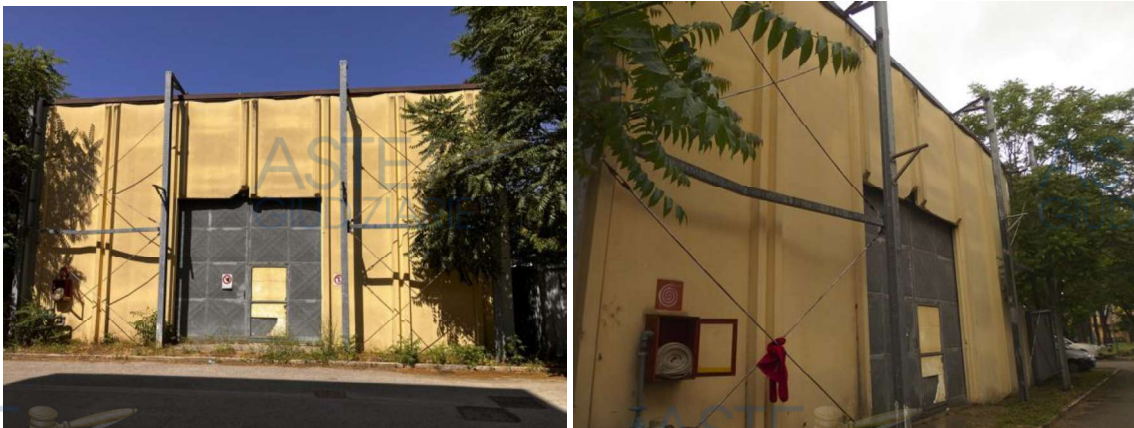
Foto 1 e 2 - Il retro del capannone con la struttura in acciaio sopra menzionata;
