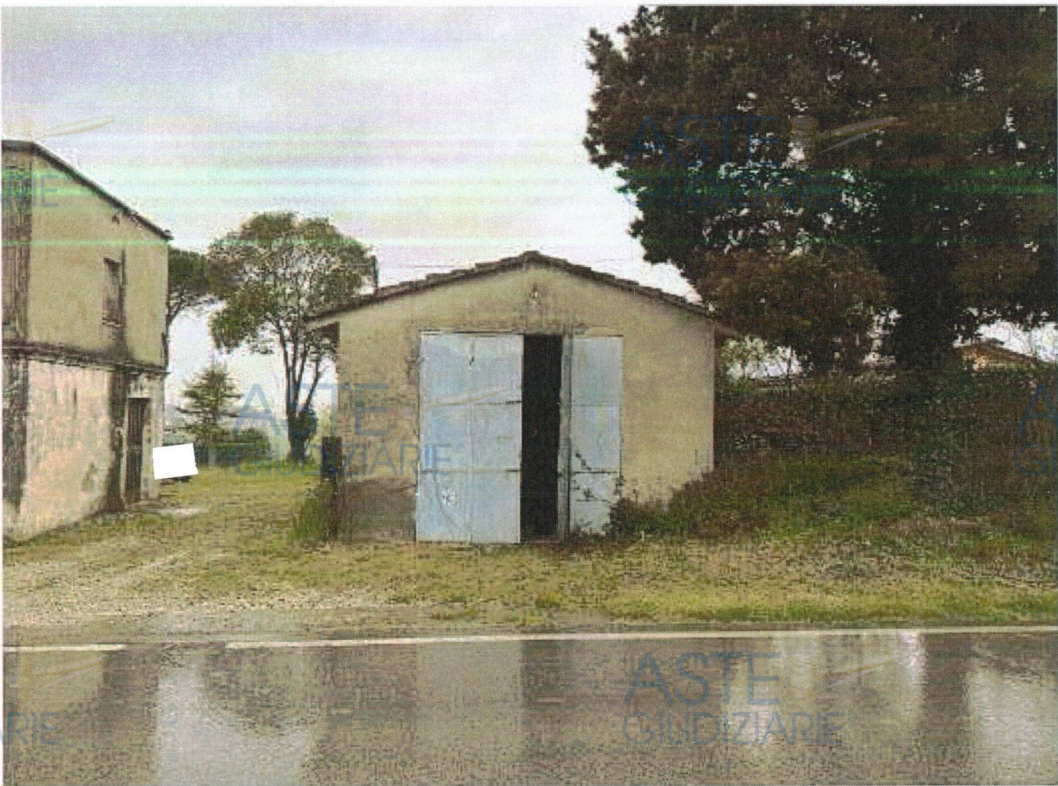
Foto 26 -ingresso rimessa attrezzi
