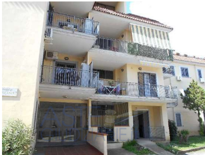
Foto 2 – Ingresso all'atrio condominiale
