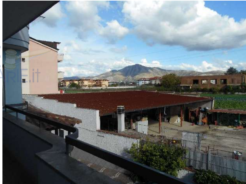
Foto 15 – Vista dall'alto della tettoia
