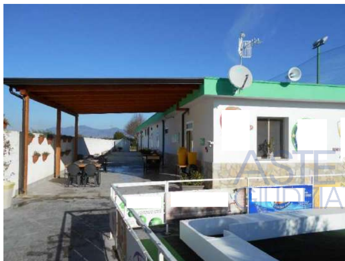
Foto 11 – Scorcio del fabbricato
