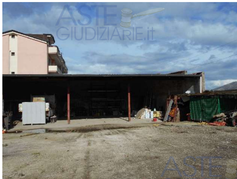
Foto 16 – Vista frontale della tettoia
