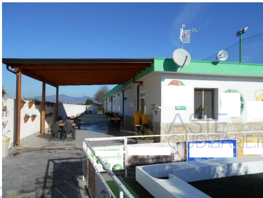
Foto 1 – Scorcio del fabbricato-servizi
