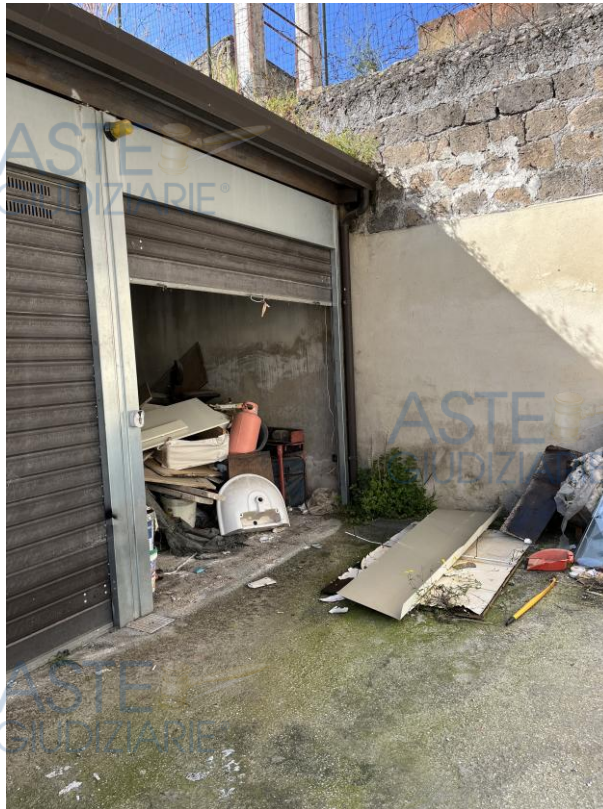
PORTA DI INGRESSO DEL BOX AUTO
