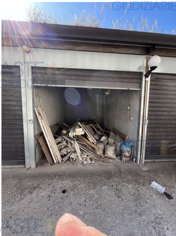
PORTA DI INGRESSO DEL BOX AUTO
