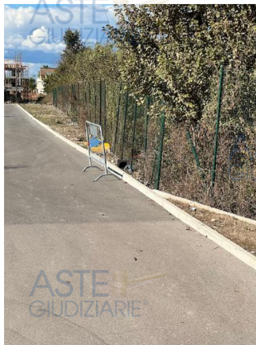
Foto n.5 – particolare confine Ovest
