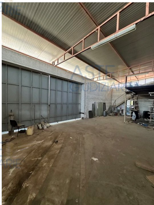
Foto n.2 – particolare area deposito
