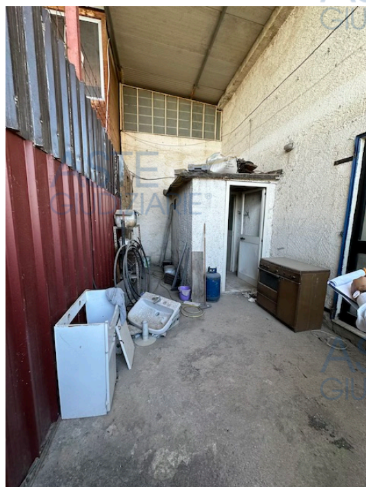
Foto n.5 – particolare corte coperta
