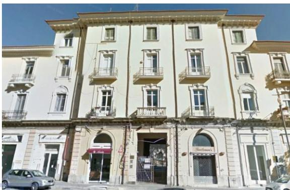
mercato rionale. Si tratta di corpi di fabbrica costituiti da piano terra, piano primo e piano secondo, con alcuni appartamenti che hanno accesso da ballatoi esterni. Al piano terra ci sono locali commerciali e depositi annessi. La struttura è interamente in muratura e si sono riscontrati – almeno nell'appartamento di vecchi solai con putrelle in ferro.
