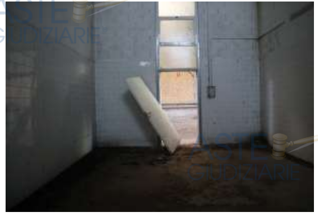
Capannone nord – blocco servizi e locali spogliatoio
