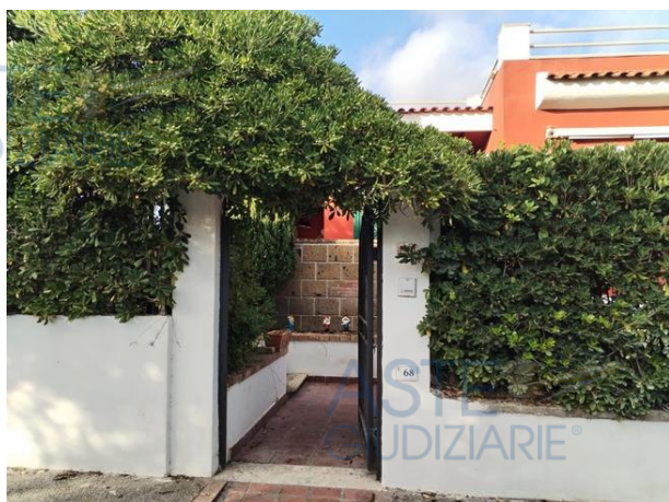
Foto n°1 - Vista del cancello pedonale - lato sud/ovest
