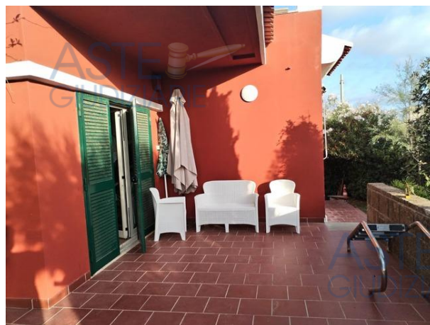
Foto n°2 - Vista area pavimentata 3 - lato sud/ovest
