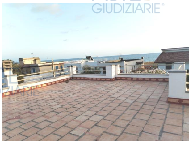
Foto n°13 - Vista lastrico solare
