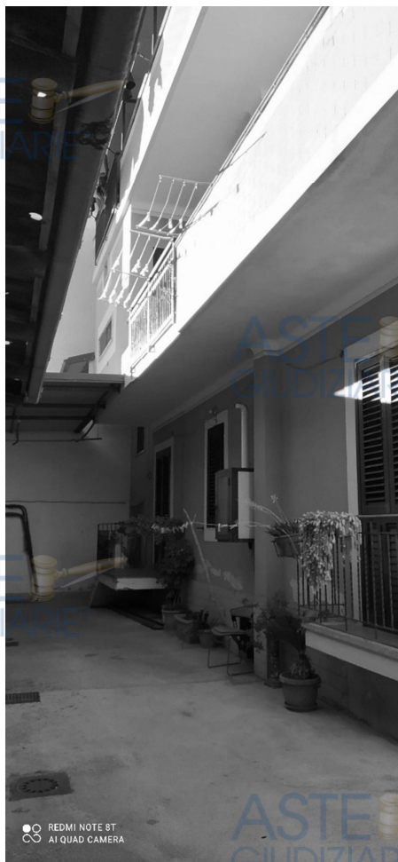
Foto 7 balcone cucina con scala
