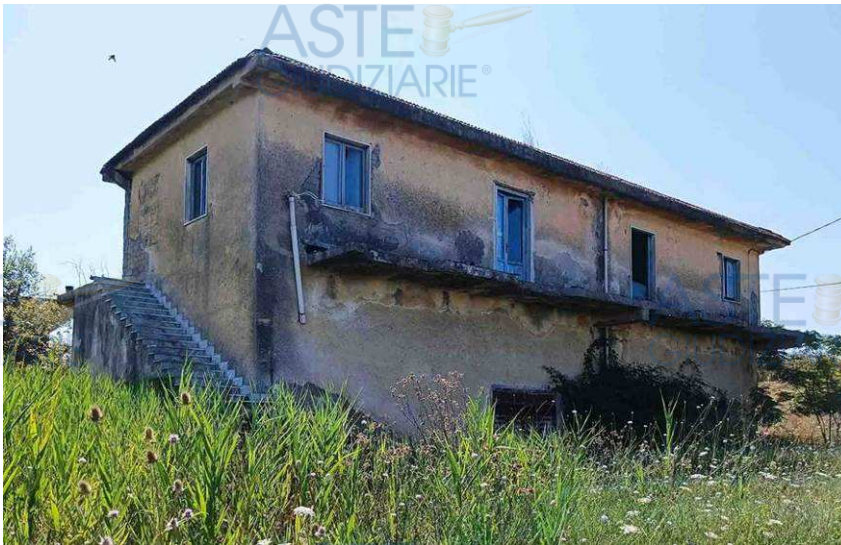
Vista esterna - lato sud/est
