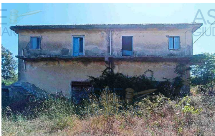
Vista esterna - lato est
