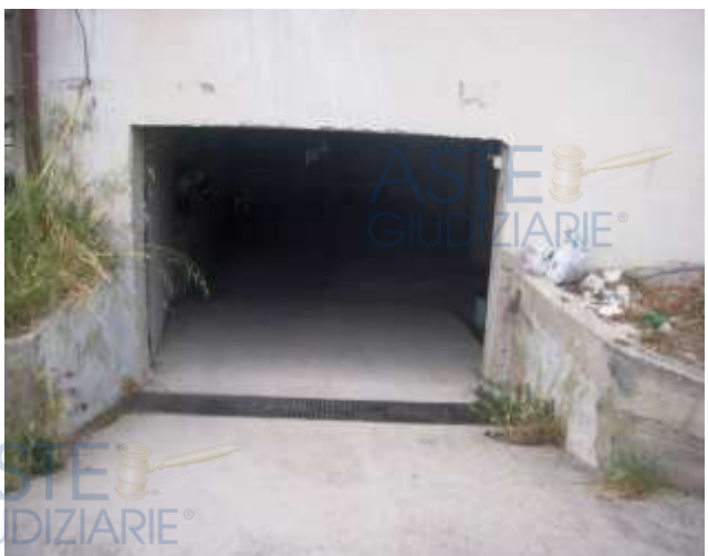
(foto 5: vista rampa)
