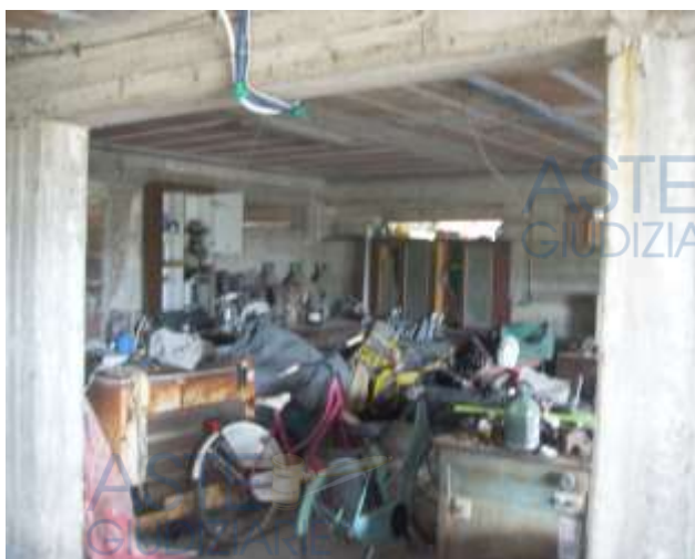
(foto 6: vista deposito)
