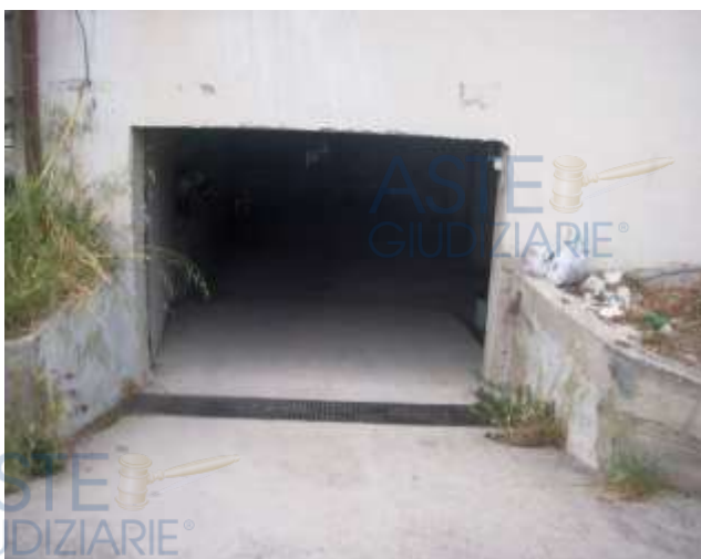
(foto 5: vista rampa)
