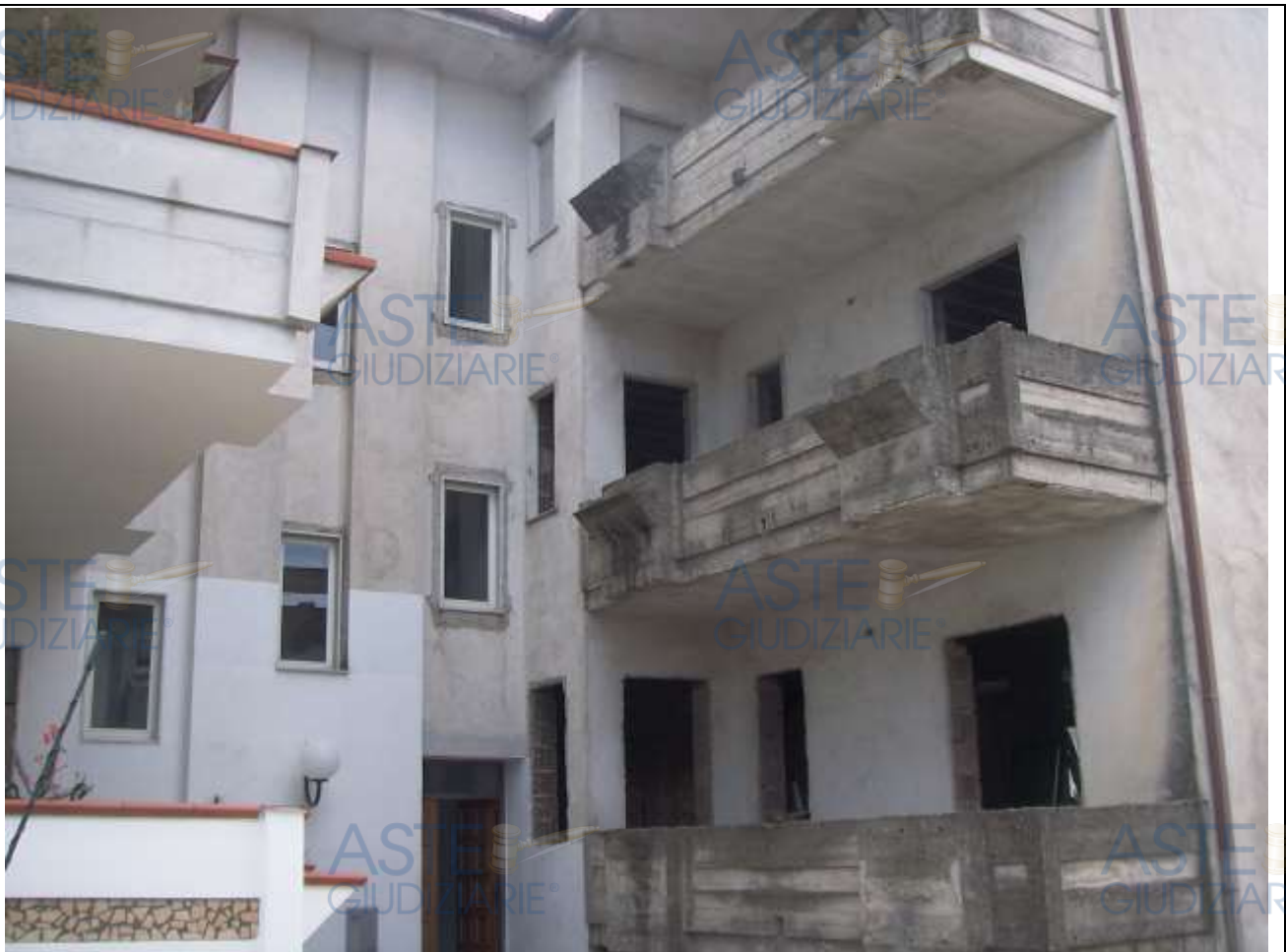
IMMOBILI IN GRAZZANISE (CE) LOTTO N. 1: APPARTAMENTO P.T.
