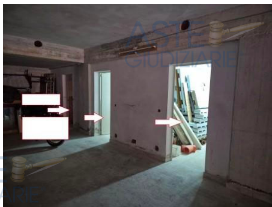
Figura 10 accesso ai tre depositi del piano seminterrato
