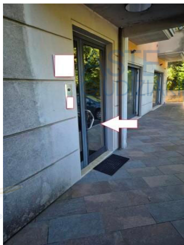
Figura 6 accesso al vano scala comune del fabbricato
