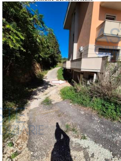
Figura 9 rampa carrabile per accesso al piano seminterrato in corso di costruzione
