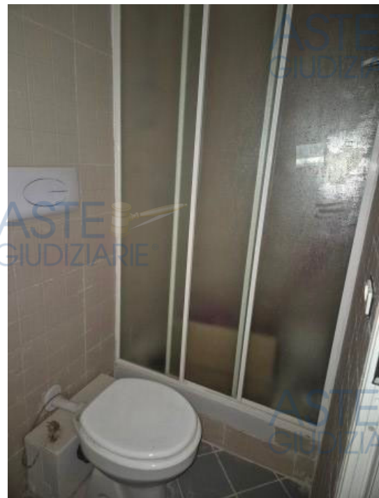
Figura 23 wc del deposito al piano seminterrato
