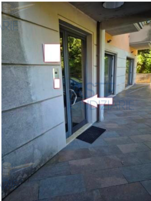
Figura 6 accesso al vano scala comune del fabbricato
