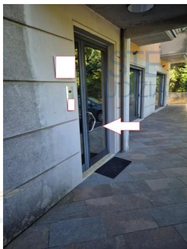
Figura 6 accesso al vano scala comune del fabbricato
