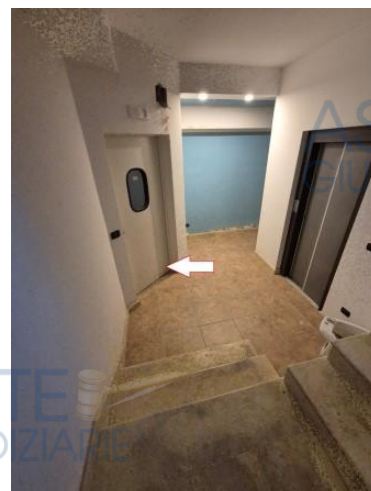
Figura 7 ingresso al piano seminterrato dal vano scala comune del fabbricato
