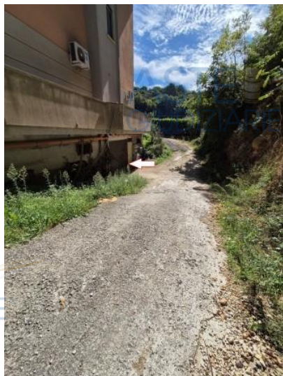
Figura 8 rampa carrabile per accesso al piano seminterrato in corso di costruzione
