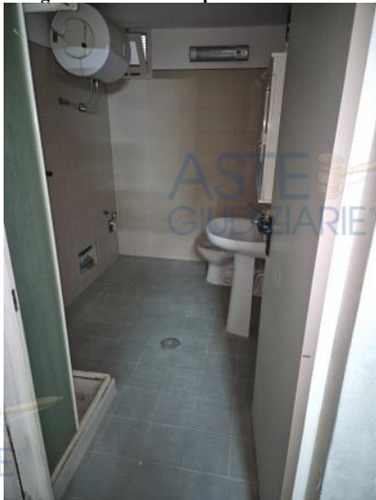
Figura 14 wc interno al box al piano seminterrato
